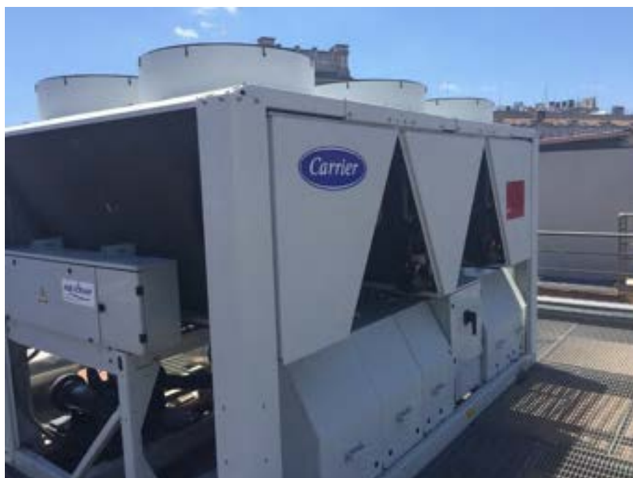
Figura 10: Pompe di calore
