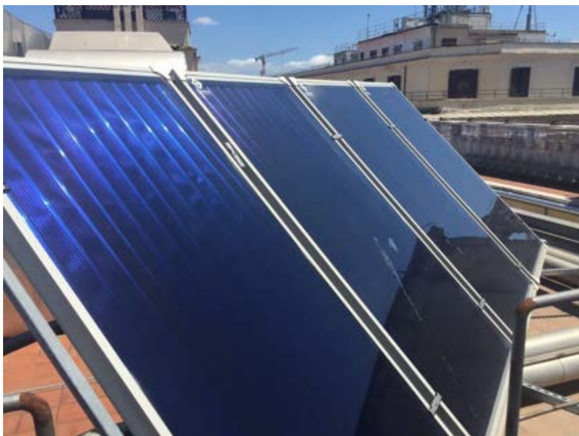
Figura 14: Collettori solari
