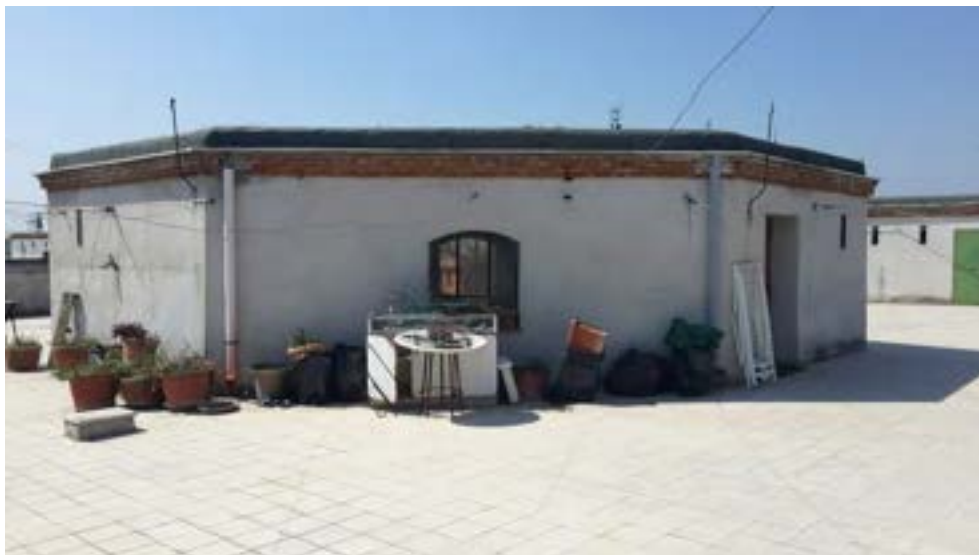
Figura 30 Torrino copertura vano scala condominiale
