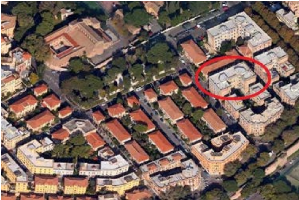
Figura 2: Edificio 7 del Lotto 1
