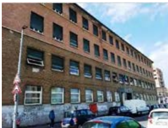
Figura 2.1 Edificio ad uso scolastico.
