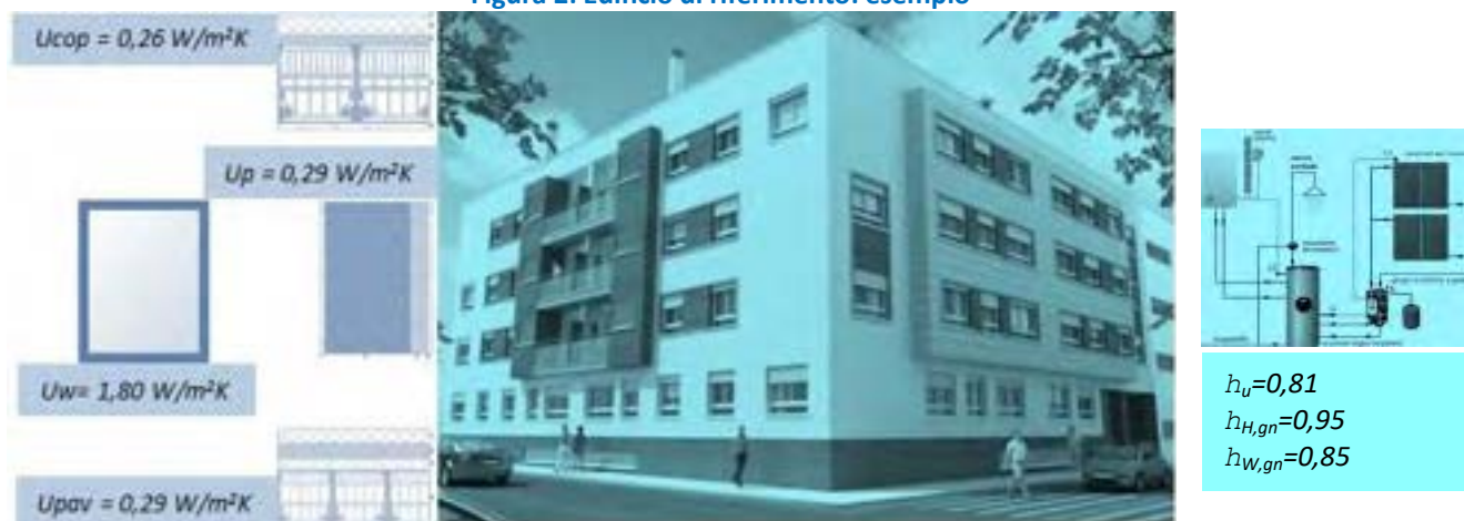
Figura 2: Edificio di riferimento: esempio
