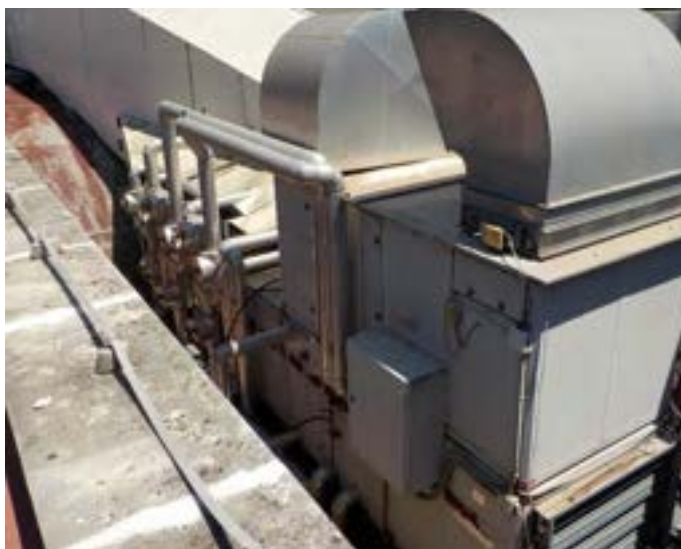
Figura 7.11 – Unità di trattamento aria e circuiti di regolazione.
