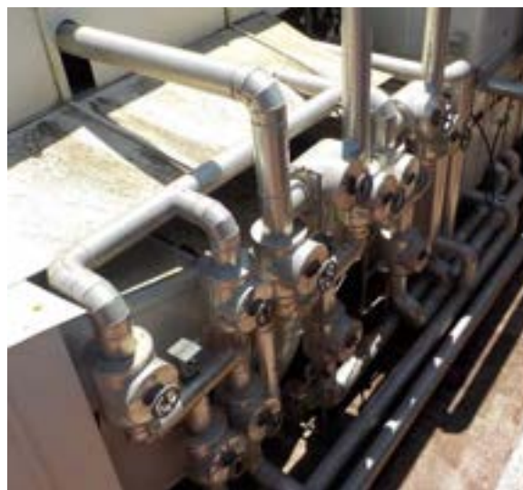
Figura 7.11 – Unità di trattamento aria e circuiti di regolazione.
