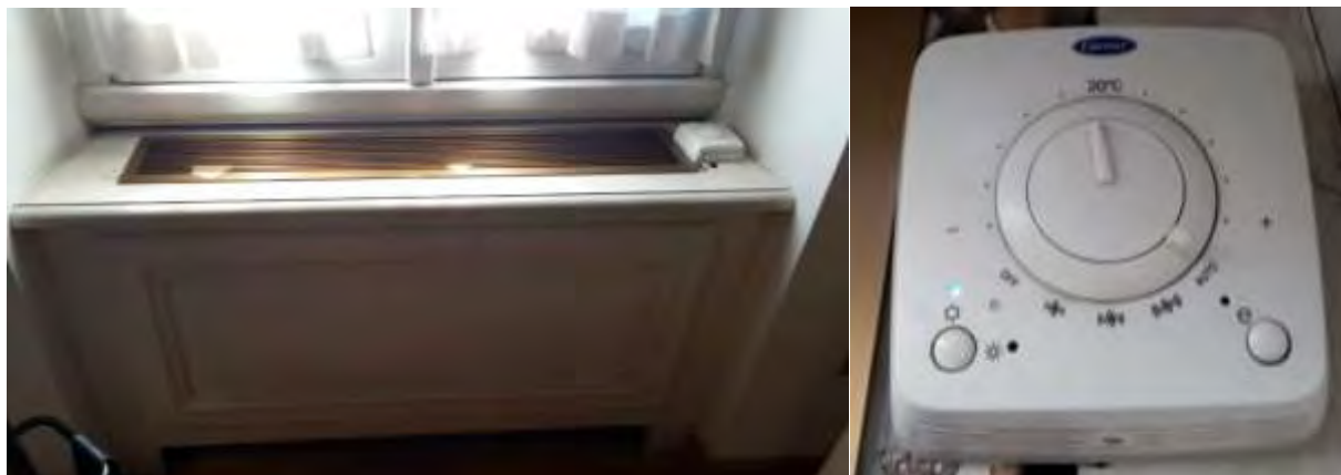
Figura 20: installazione tipo dei ventilconvettori negli uffici con sistema di regolazione a lato macchina
