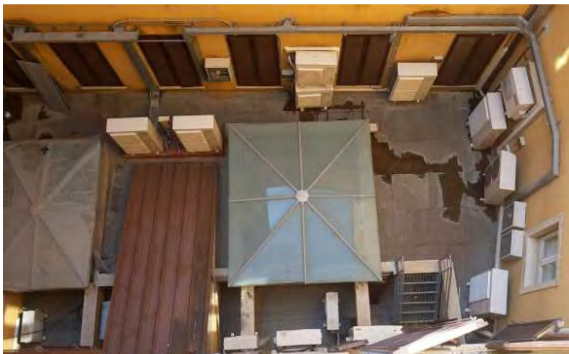
Figura 19: Unità esterne a servizio del CED al primo piano
