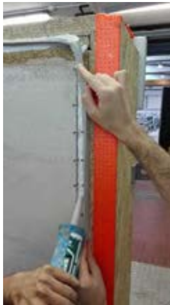
Figura 5: Posa del silicone sigillante
