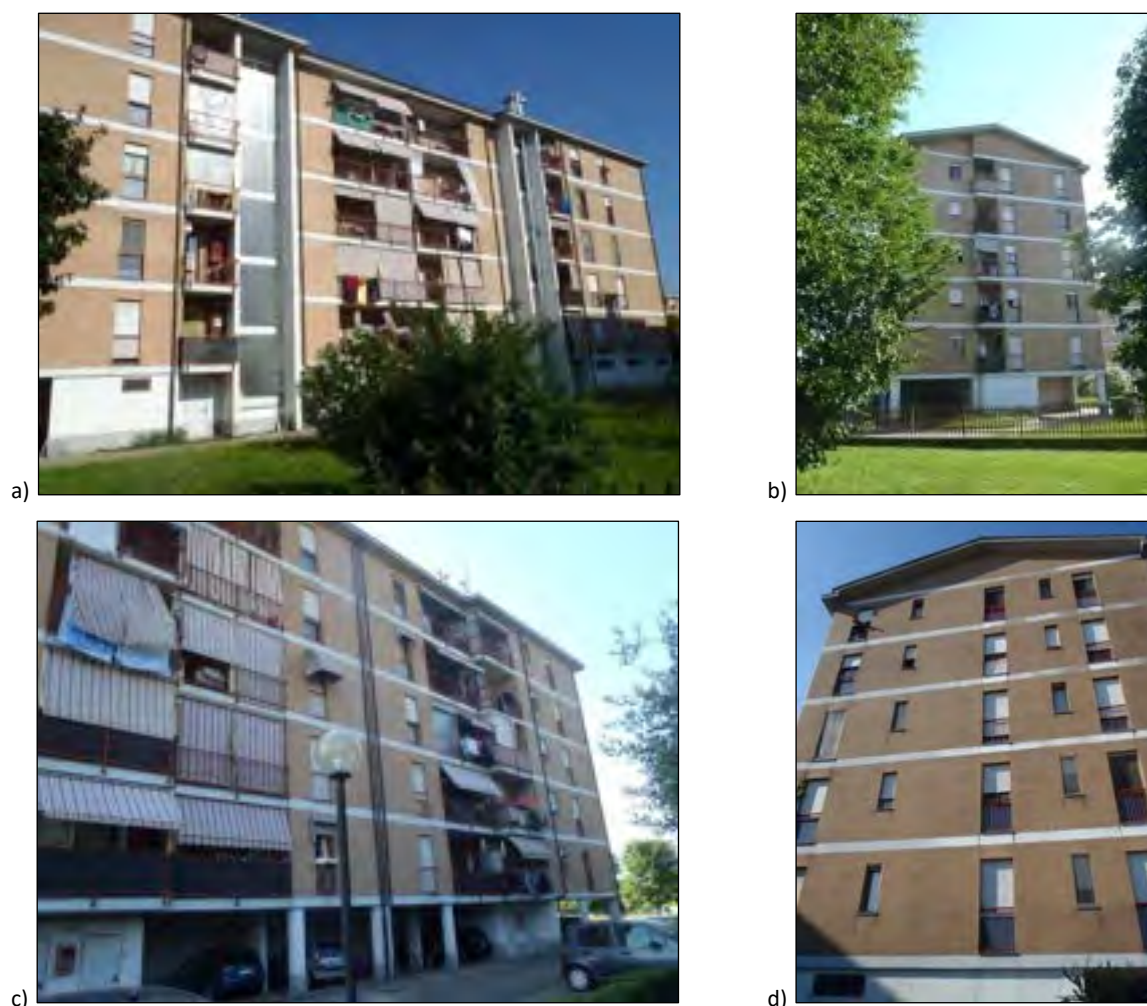
Figura 2.3. Facciate dell'edificio. a) Lotto A - Est; b) Lotto A - Nord; c) Lotto A - Ovest; d) Lotto A - Sud.
