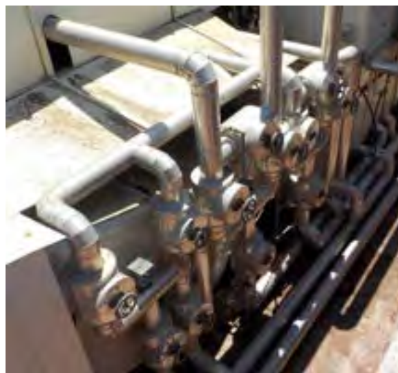
Figura 3.11 – Unità di trattamento aria e circuiti di regolazione.
