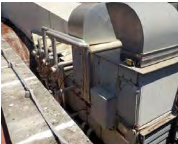
Figura 3.11 – Unità di trattamento aria e circuiti di regolazione.
