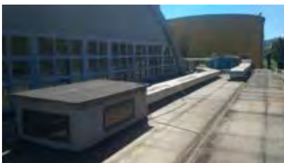
Figura 5.2.5-1. Canalizzazioni esterne ed interne di distribuzione dell'aria nella zona commerciale
