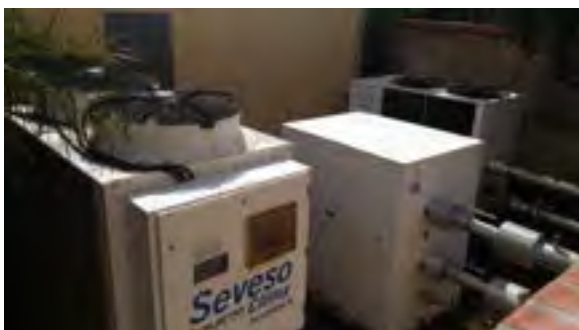
Figura 5.2.1. Generatore a pompa di calore
