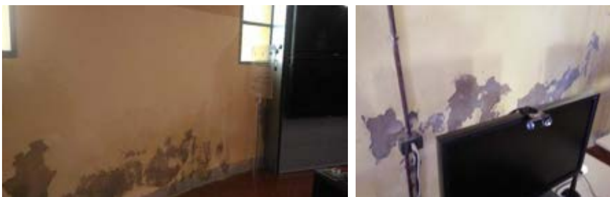
Figura 50. Chiari segni di degrado per umidità ascendente nella biglietteria del museo del carbone
