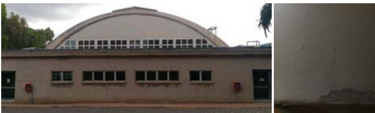
Figura 51. Segno esterno di umidità ascendente, segno nella muratura interna ne museo del carbone
