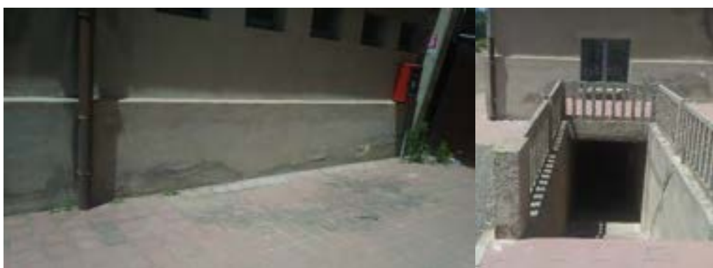
Figura 66. Degrado delle pavimentazioni e segni di degrado per umidità ascendente Museo Carbone
