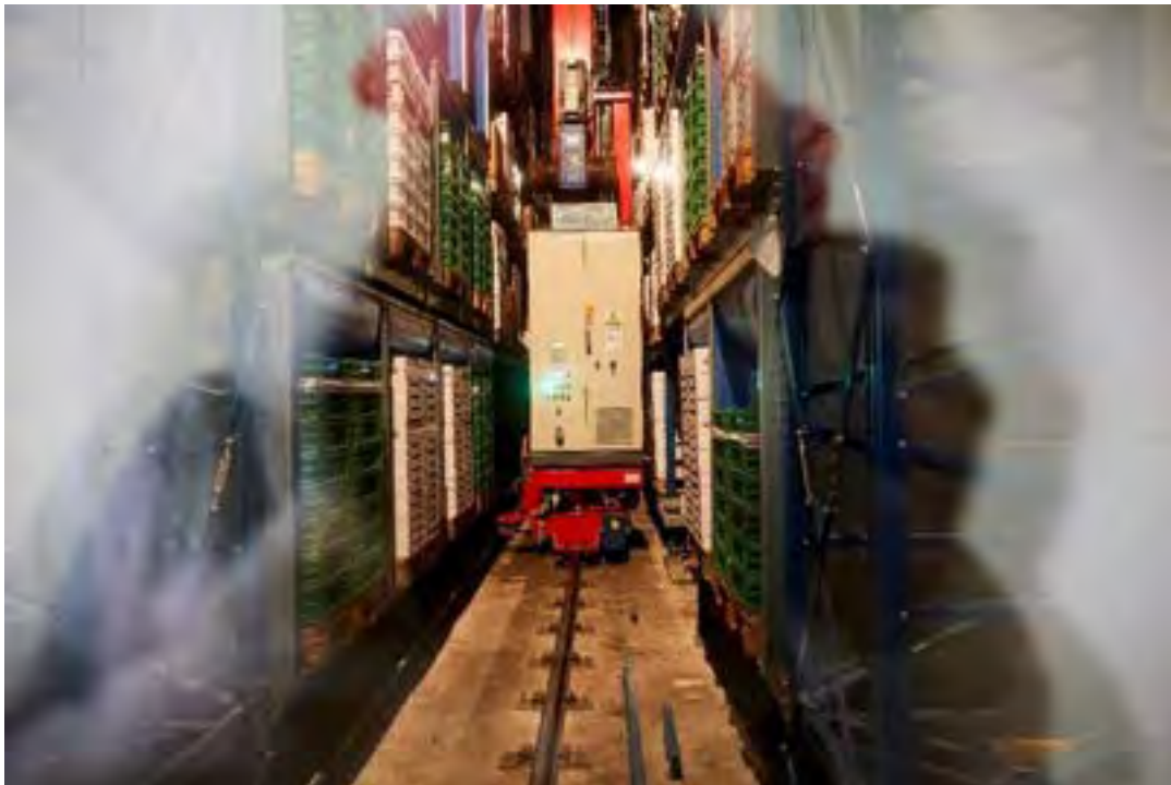
Figura 11 Magazzino refrigerato ed automatizzato per la conservazione dei prodotti
