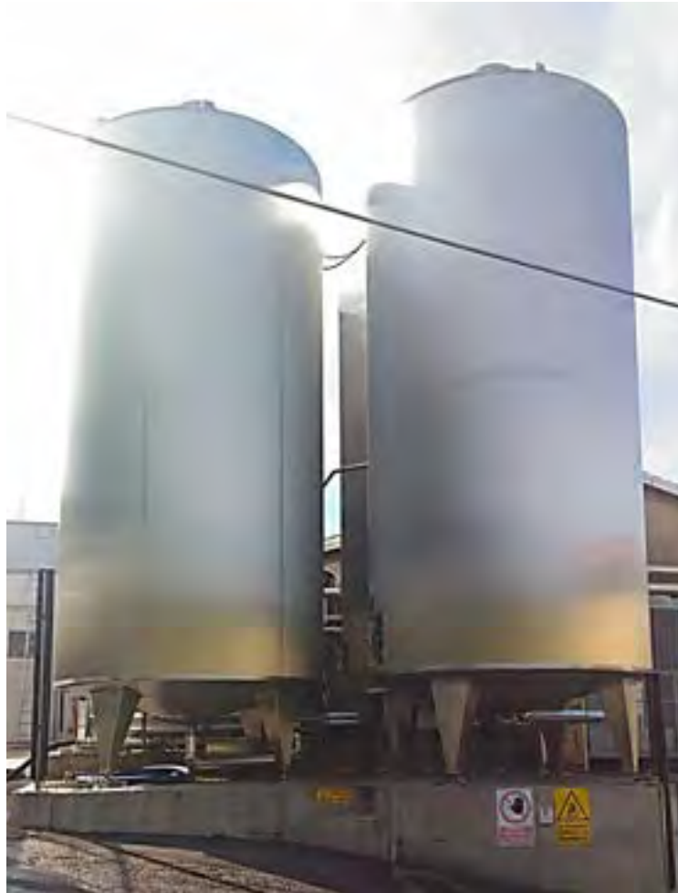
Figura 9: Serbatoi stoccaggio siero
