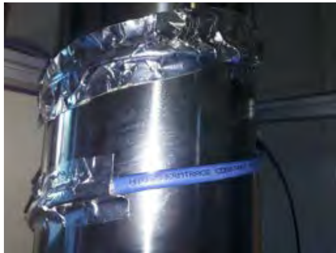
Figura 3.9 Foto del cavo scaldante avvolto sul condotto del letto MOF in fase di montaggio
