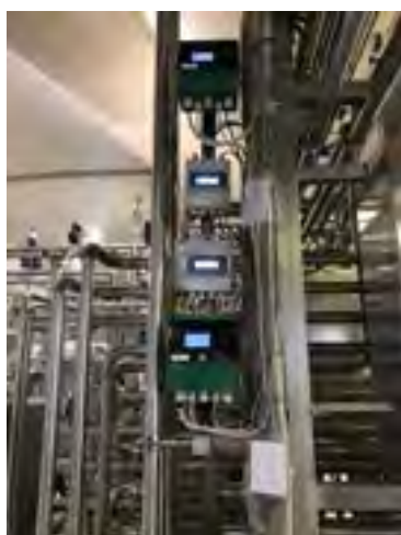
Figura 8: Misuratori di consumi elettrici dei reparti di produzione
