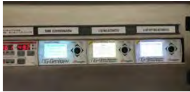
Figura 10: Gateway e misuratori assorbimento elettrico chillers
