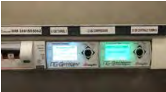
Figura 10: Gateway e misuratori assorbimento elettrico chillers
