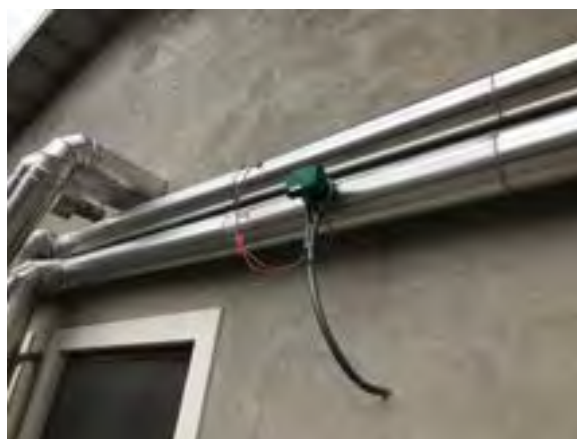
Figura 7: Misuratore energia termica – Linea Vapore al processo
