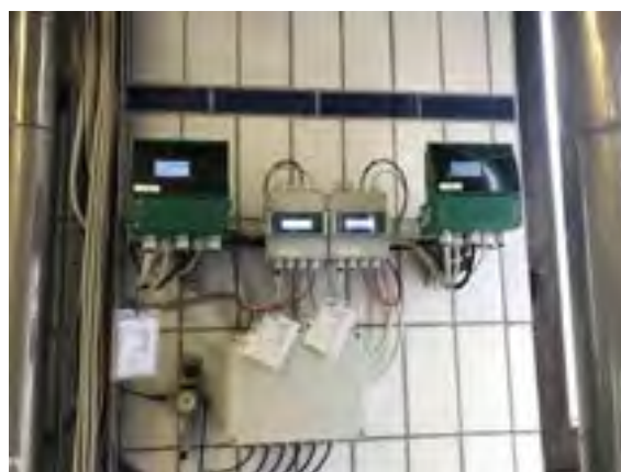
Figura 7: Misuratore energia termica – Linea Vapore al processo
