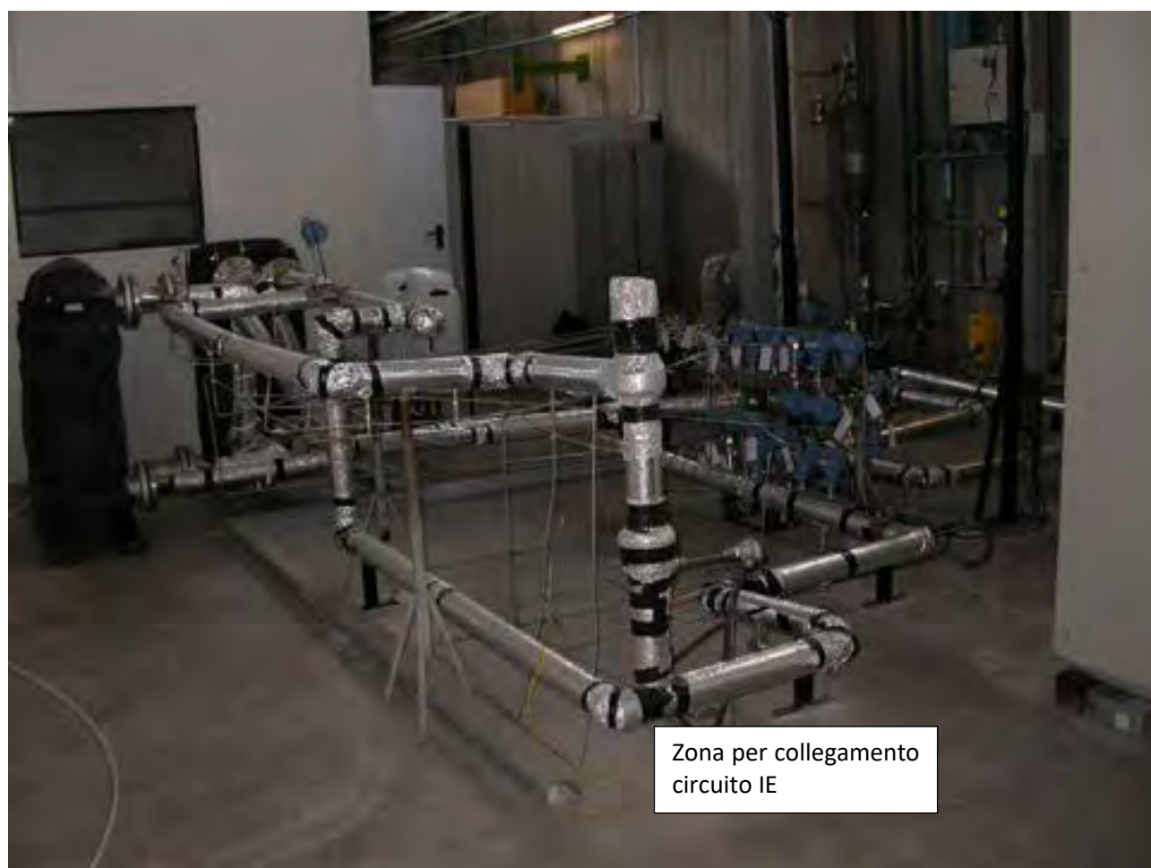
Figura 3 – Immagine impianto VASIB
