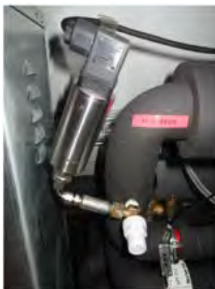
Figura 4. Sensore di pressione GE DRUCK serie PTX 600
