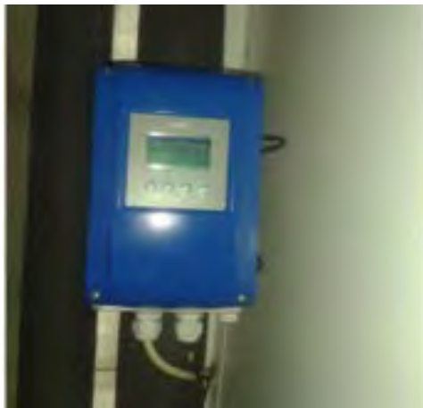
Figura 5. Misuratore di portata Krohne optiflux 5000
