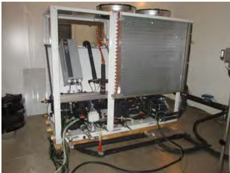
Figura 21. Prototipo di pompa di calore reversibile da 30 kW (prima dell'inserimento del separatore d'olio)
