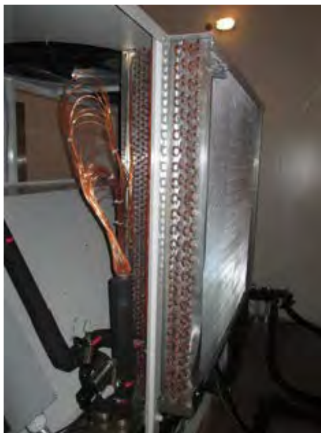
Figura 22. Batterie alettate
