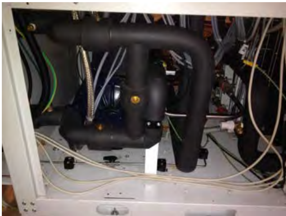
Figura 27. Sezione di by-pass del separatore d'olio
