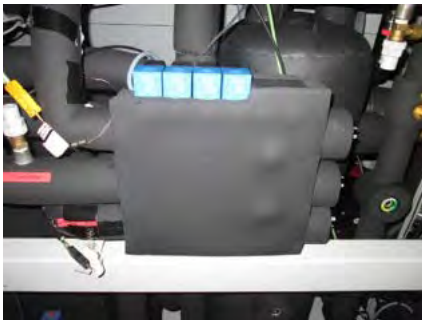
Figura 23. Particolare del pacco eiettori
