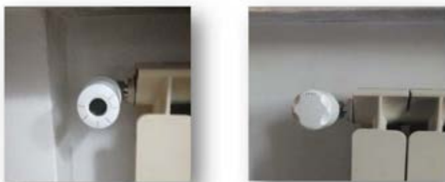
Figura 21- Smart Valve: a sinistra Danfoss , a destra Caleffi
