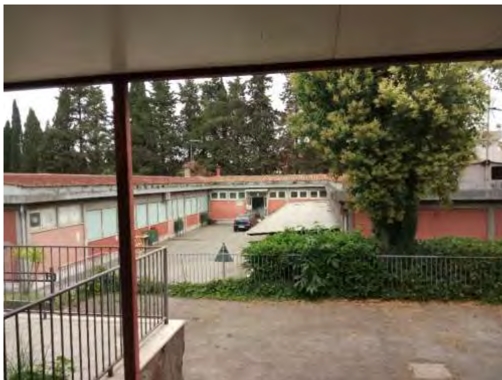
Fig.5.1.3 – Prefabbricati di colore rosso
