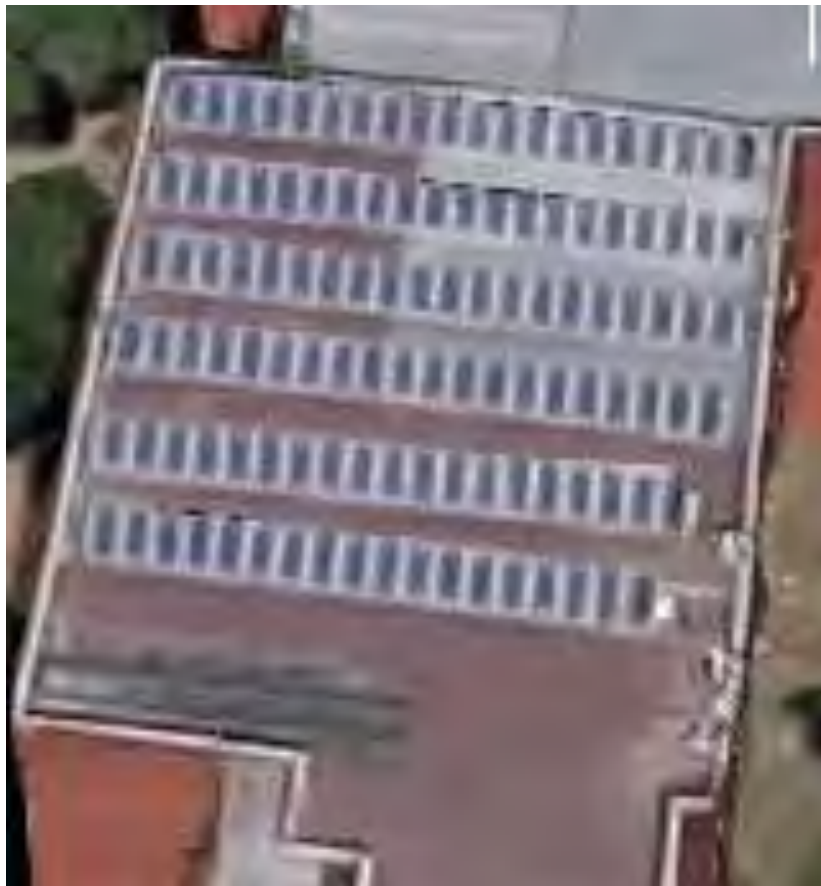
Fig.4.3.5 – Immagine satellitare dei pannelli solari
