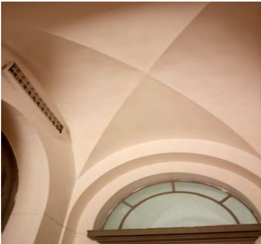
Fig.3.2.1 – Pareti e soffitto dell'edificio principale
