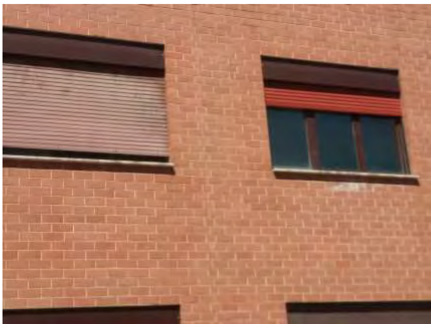
Fig.4.2.3 – Finestra con tapparelle in PVC
