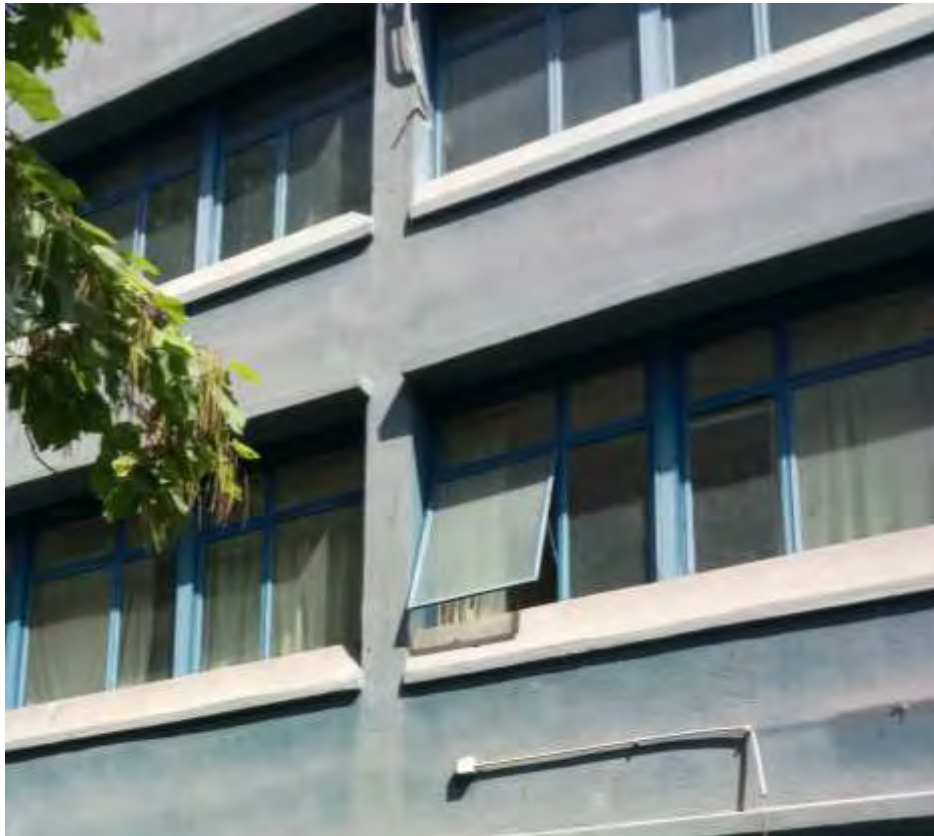
Fig.13.2.3 – Schermature delle finestre
