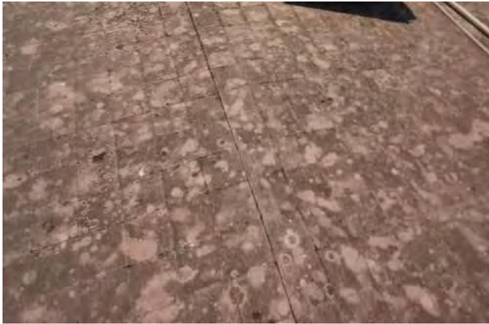
Fig.3.2.6 – Copertura del terrazzo esterno mediante mattonelle con graniglia di marmo
