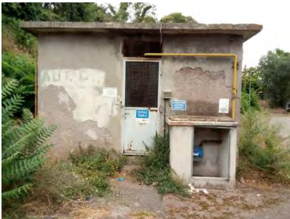
Fig.5.3.1 – Centrale non accessibile
