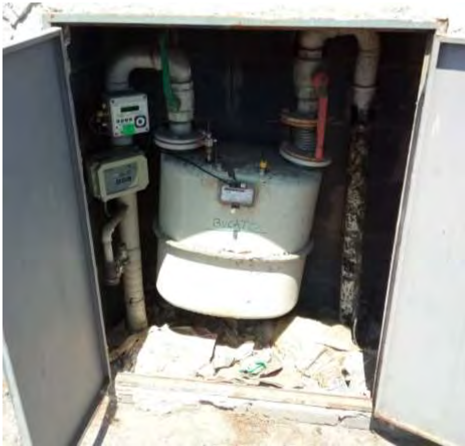
Fig.10.3.2 – Contatore del GAS
