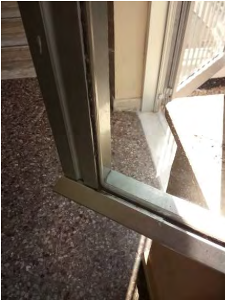
Fig.9.2.3 – Infissi in alluminio con vetro singolo
