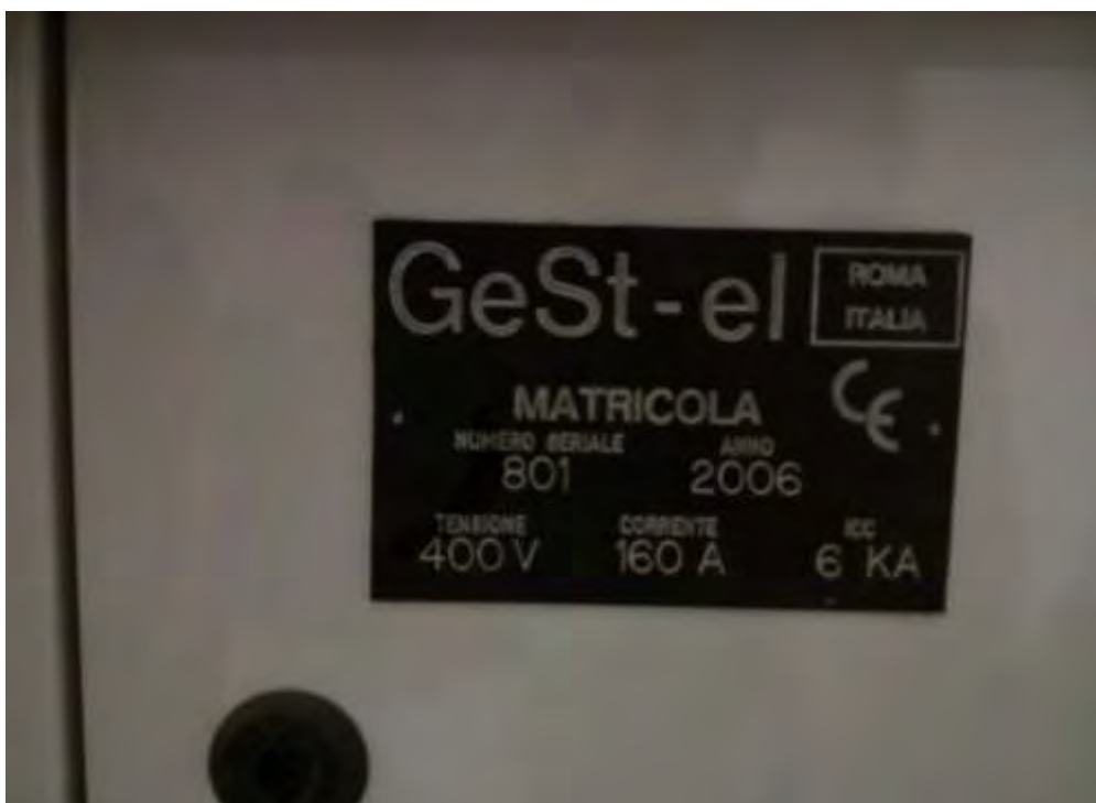
Fig.3.3.10 - Dati di targa del quadro elettrico
