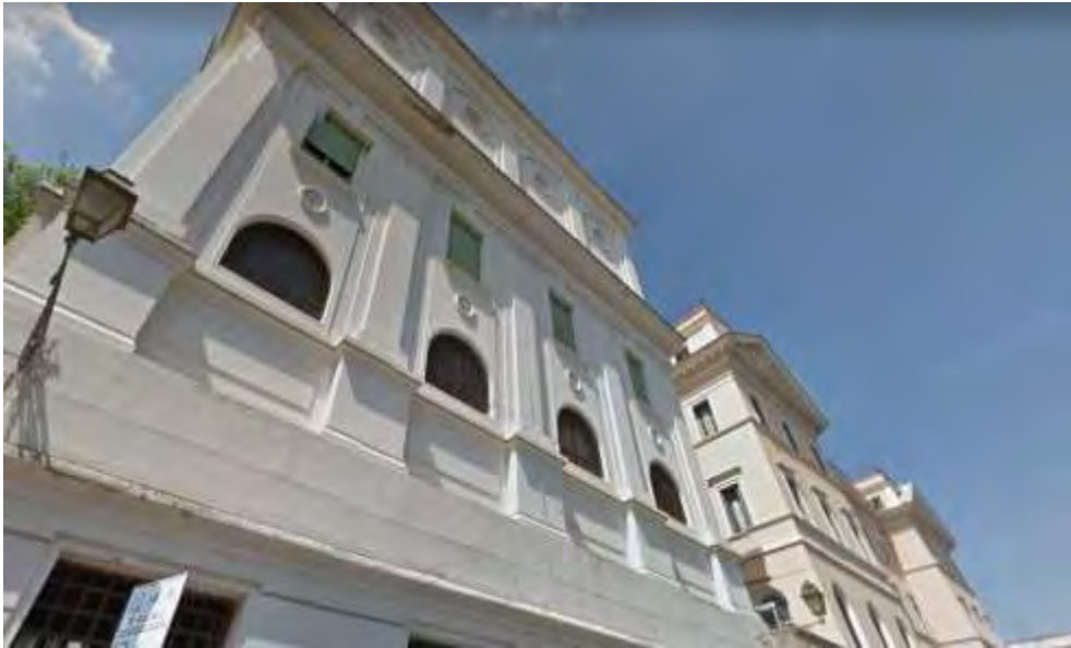
Fig.3.1.2 – Facciata esterna della palazzina B
