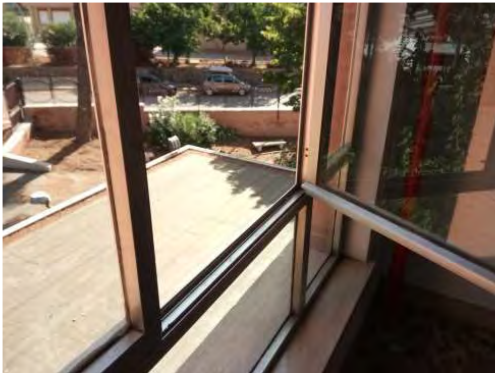
Fig.11.2.3 – Infissi in alluminio con vetro singolo
