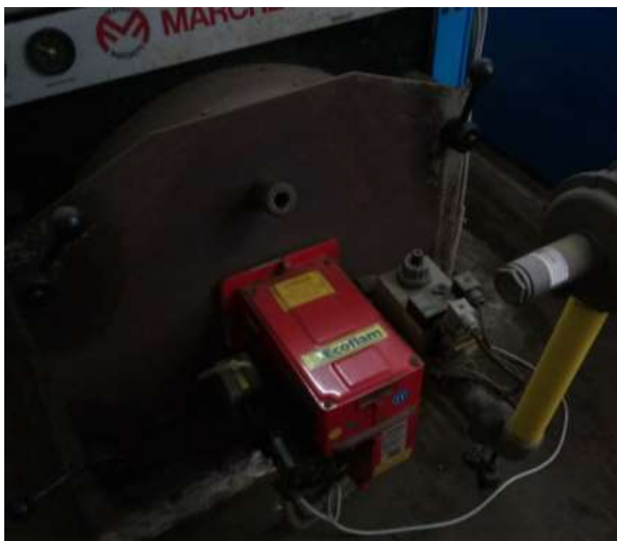
Fig.3.3.3 - Bruciatore da 180 kW
