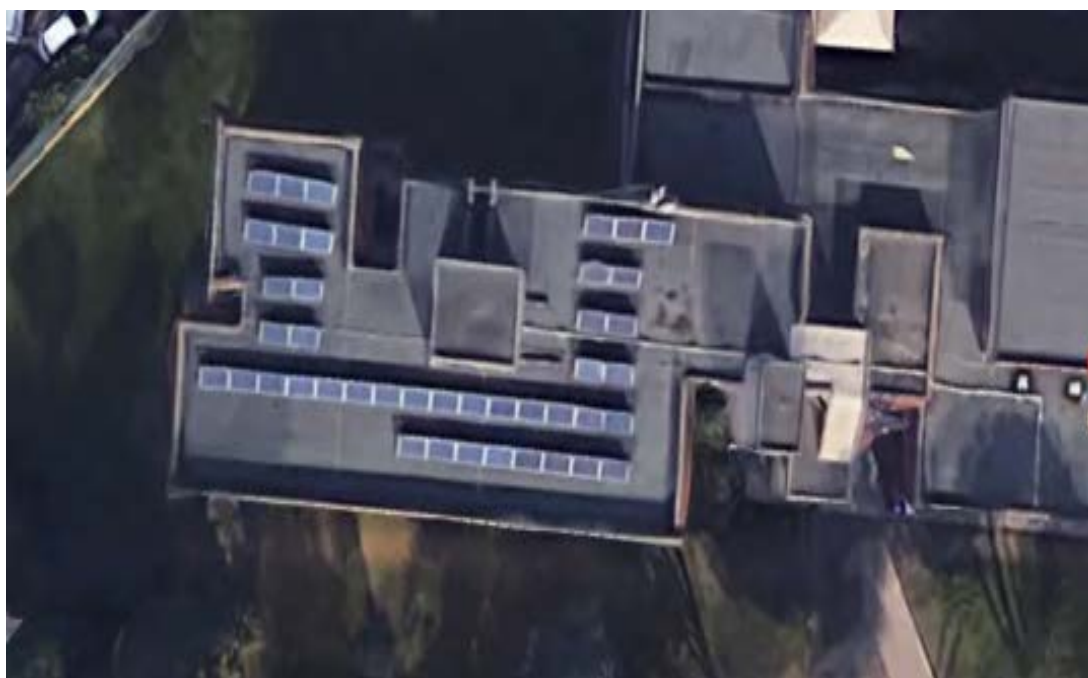
Fig.12.3.1 – Immagine satellitare dell'impianto fotovoltaico
