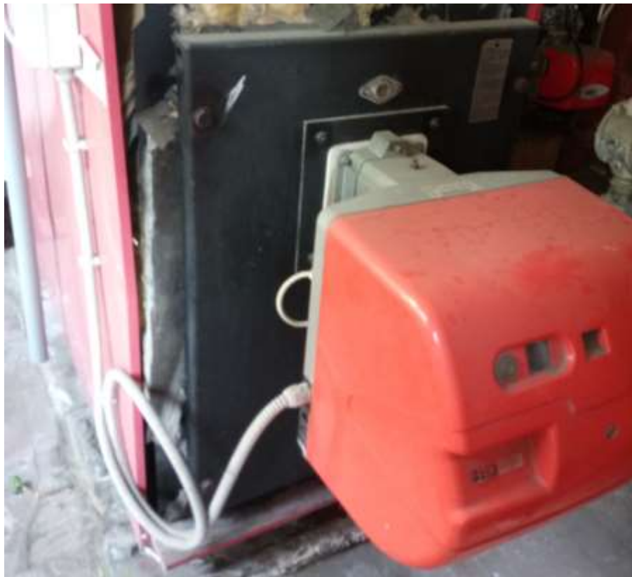
Fig.3.3.5 - Bruciatore da 325 kW
