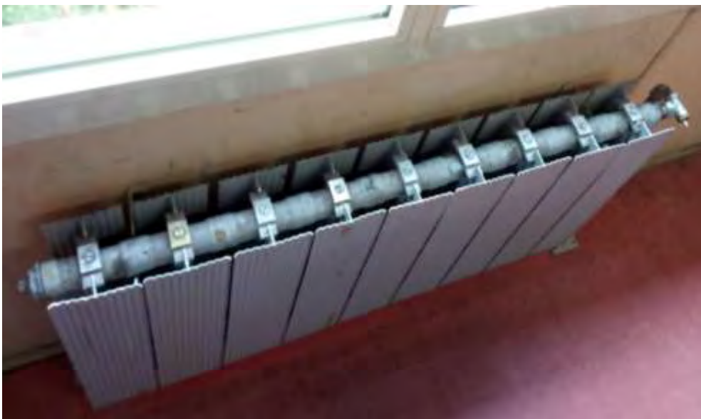
Fig.5.3.7 – Termosifoni senza valvole termostate
