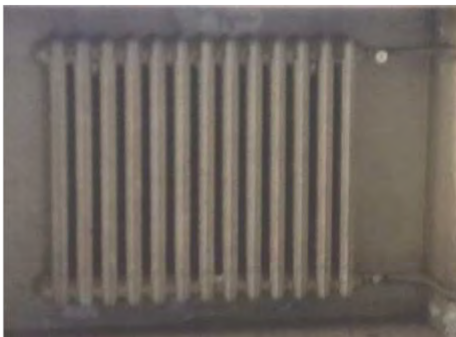
Fig.8.3.1 – Termosifoni d’aula con l’assenza di valvole termostatate
