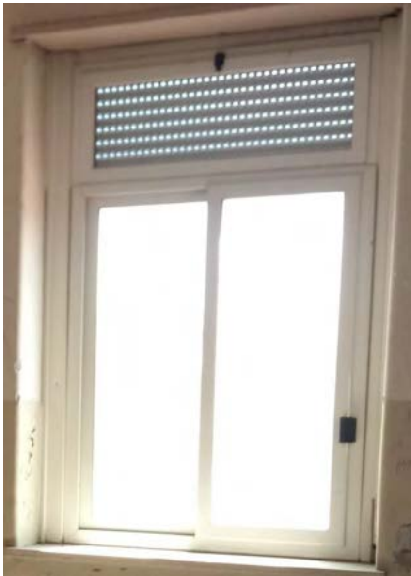
Fig.8.2.3 – Finestratura con infissi in alluminio e doppio vetro
