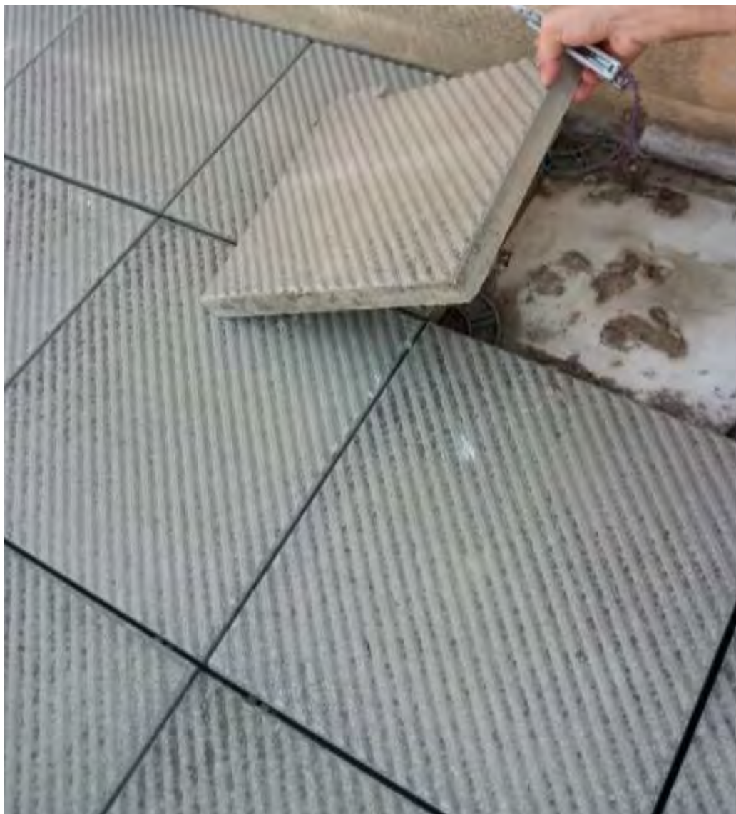
Fig.9.2.8 – Copertura ventilata poggiata su plastica
