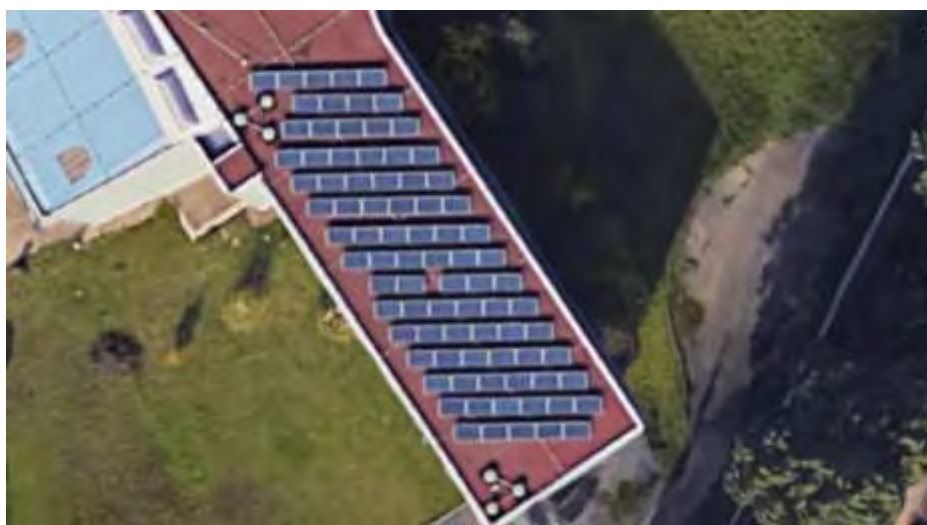
Fig.10.3.5 – Immagine satellitare dei pannelli fotovoltaici
