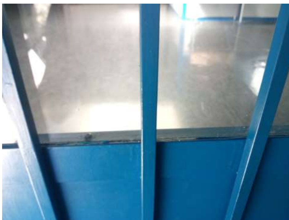
Fig.13.2.2 – Infissi in ferro con vetro singolo
