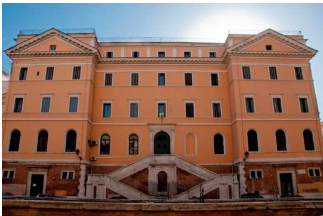
Fig.3.1.1 – Liceo Cavour, facciata principale edificio A con ingresso
