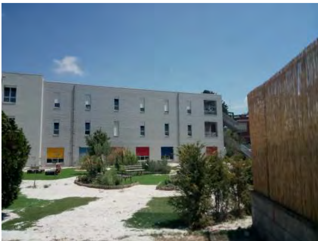
Fig.10.1.2 – Facciata laterale del liceo Keplero
