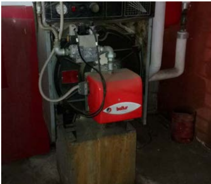
Fig.3.3.6 Bruciatore da 35 kW
