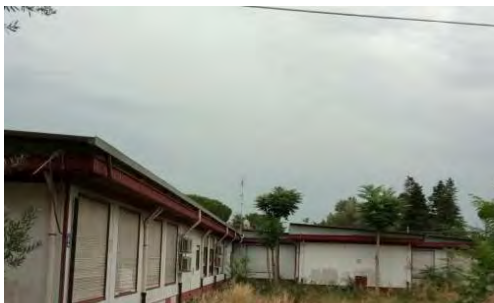
Fig.5.2.10 – Tetto a singola falda spiovente
