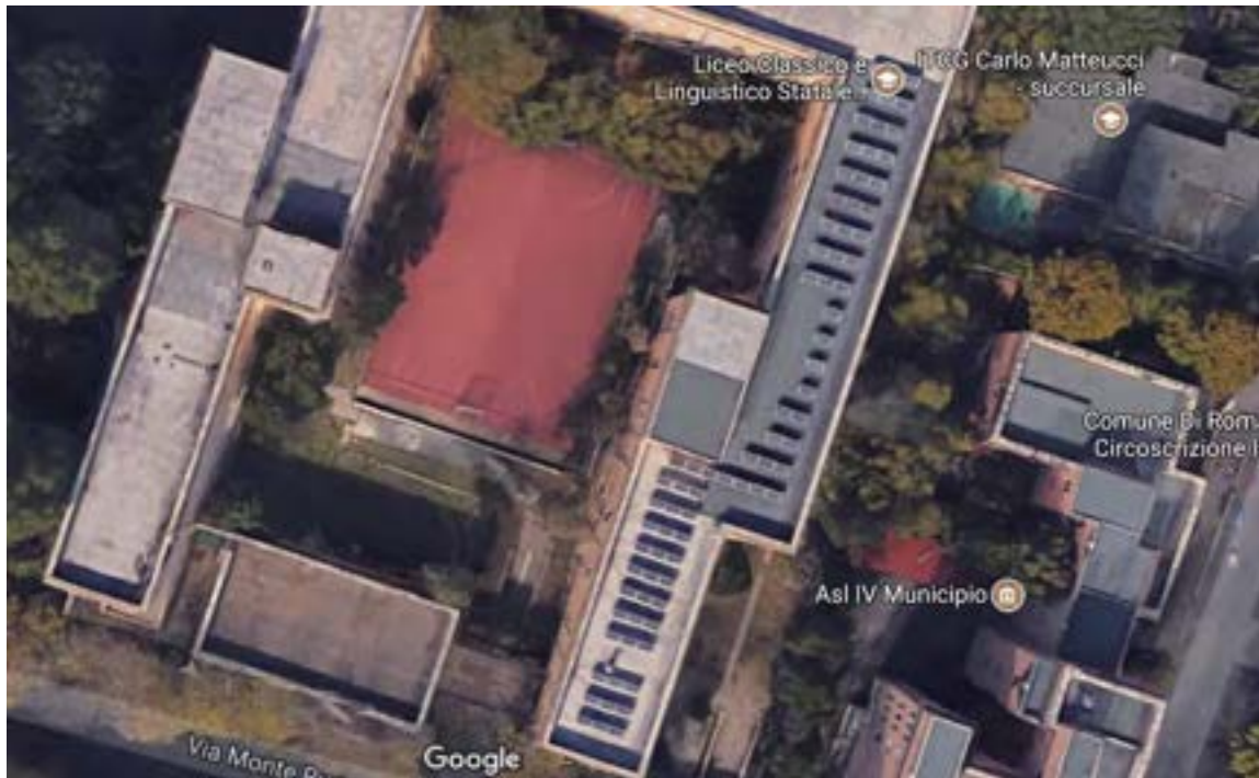
Fig.8.3.3 – Immagine satellitare dell'impianto fotovoltaico
