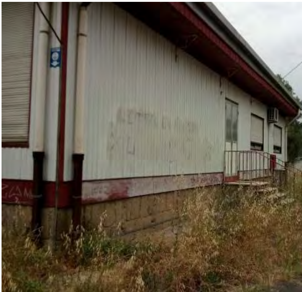
Fig.5.2.1 – Parete esterna edificio
