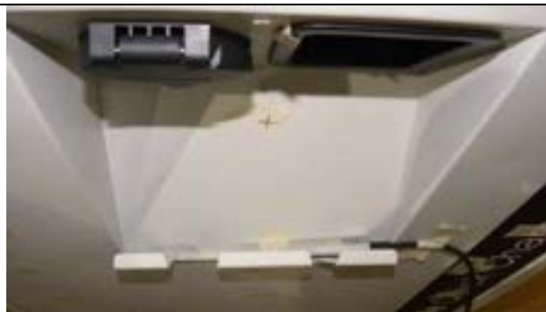
Figura 52 – Punto di misura sul lato A nel vano connettore
