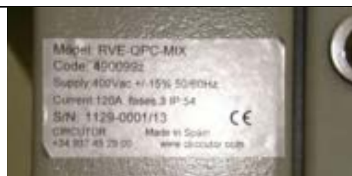
Figura 4 – Targa identificativa riportata sul lato D
