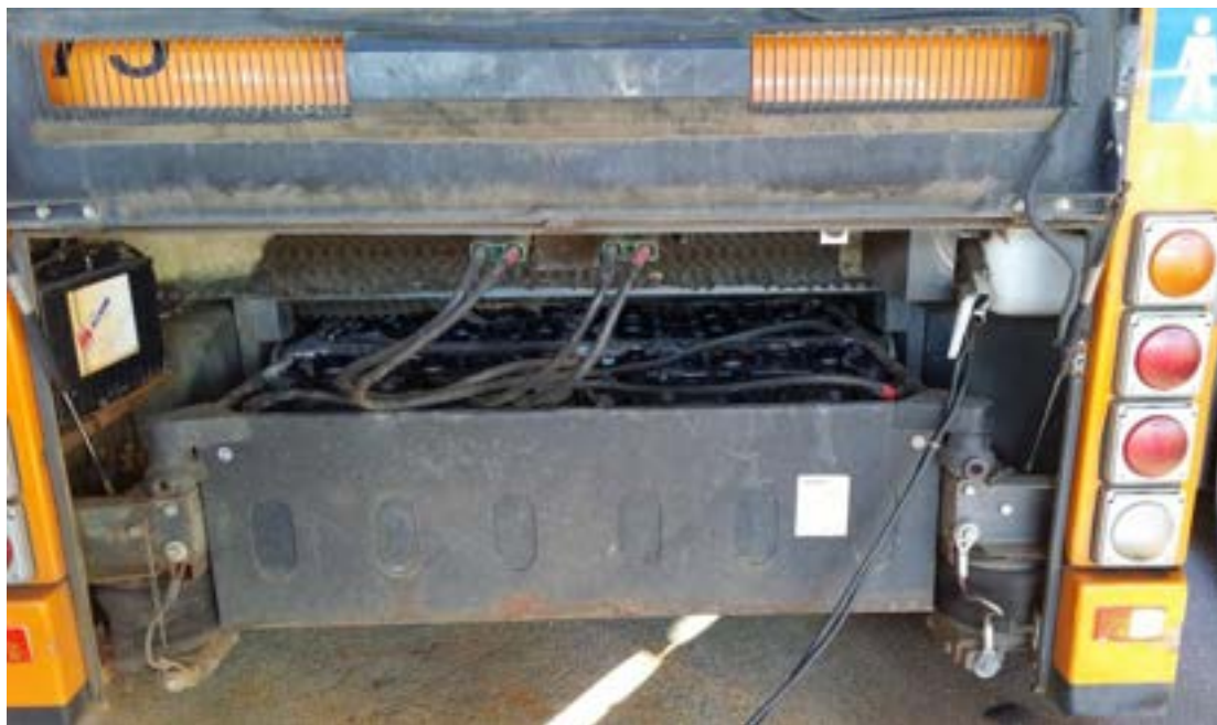
Figura 10 Un dettaglio delle batterie installate sul veicolo TECNOBUS durante la ricarica
