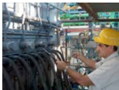
Figura 12 Inserzione delle sonde nella porta P1 e P3
