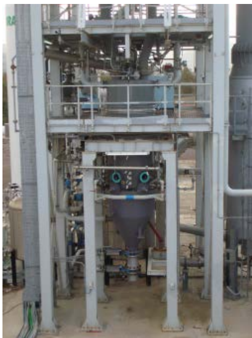
Figura 3: il gassificatore pilota durante la fase di montaggio
