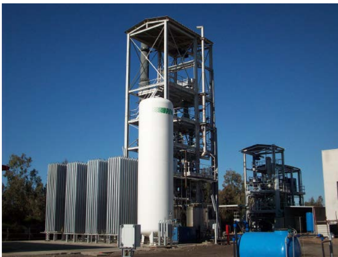
Figura 1: La piattaforma pilota Sotacarbo
