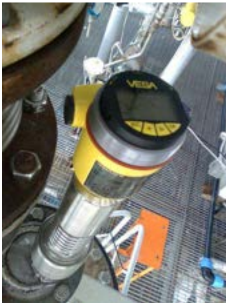
Fig. 17: Vista di dettaglio del misuratore di livello carbone.
