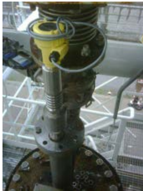
Fig. 17: Vista di dettaglio del misuratore di livello carbone.
