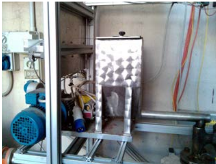
Figura 19: Tramoggia di carico con coclea di alimentazione.
