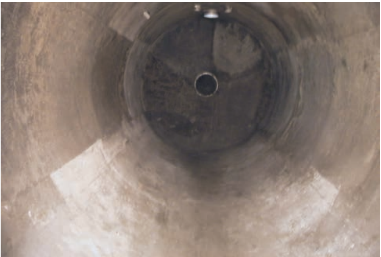
Figura 16: Fine coibentazione interna
