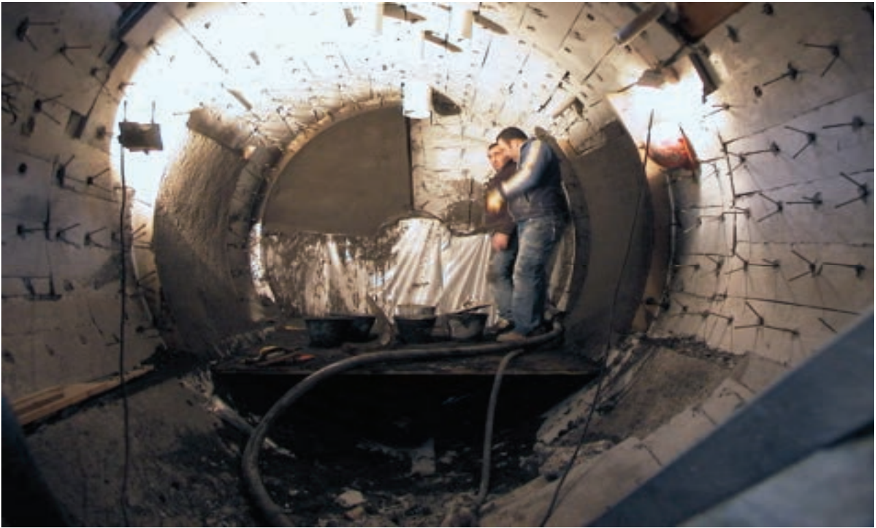
Figura 15: corso d'opera dell'attività di coibentazione
