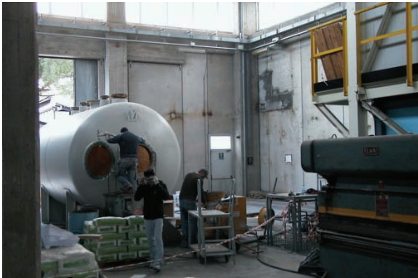
Figura 14: Fasi coibentazione con materiale refrattario in polvere
