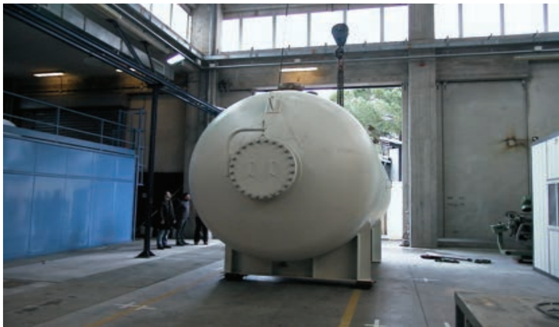
Figura 13: Fasi di posizionamento del vessel
