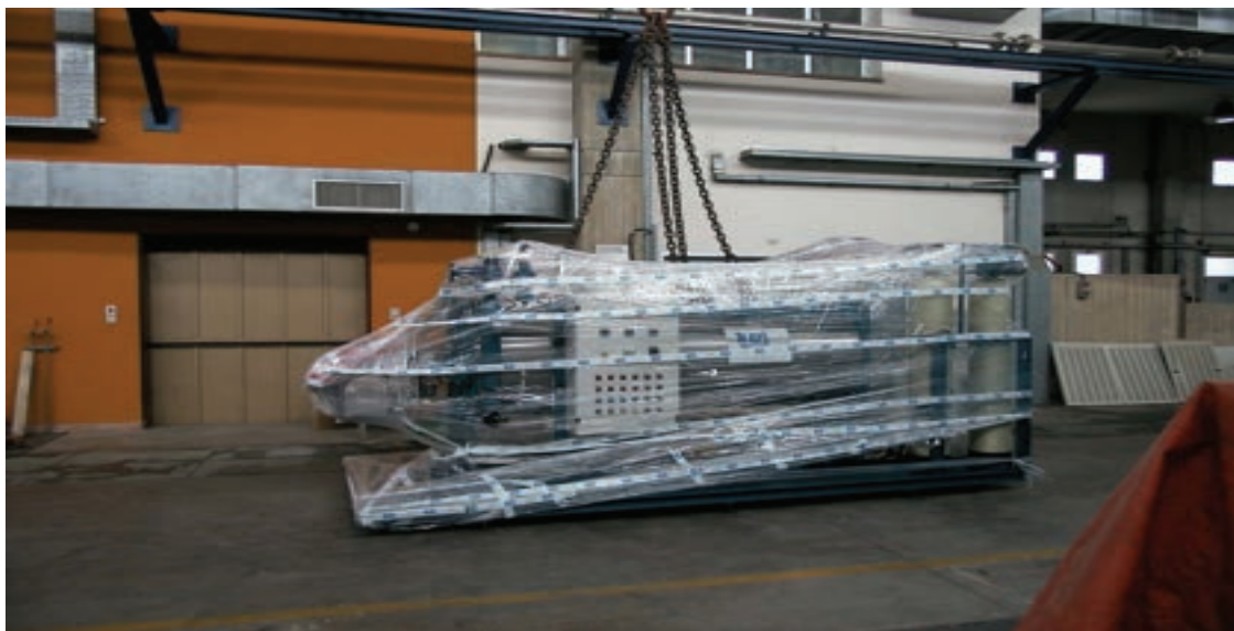
Figura 19: Installazione del generatore di vapore
