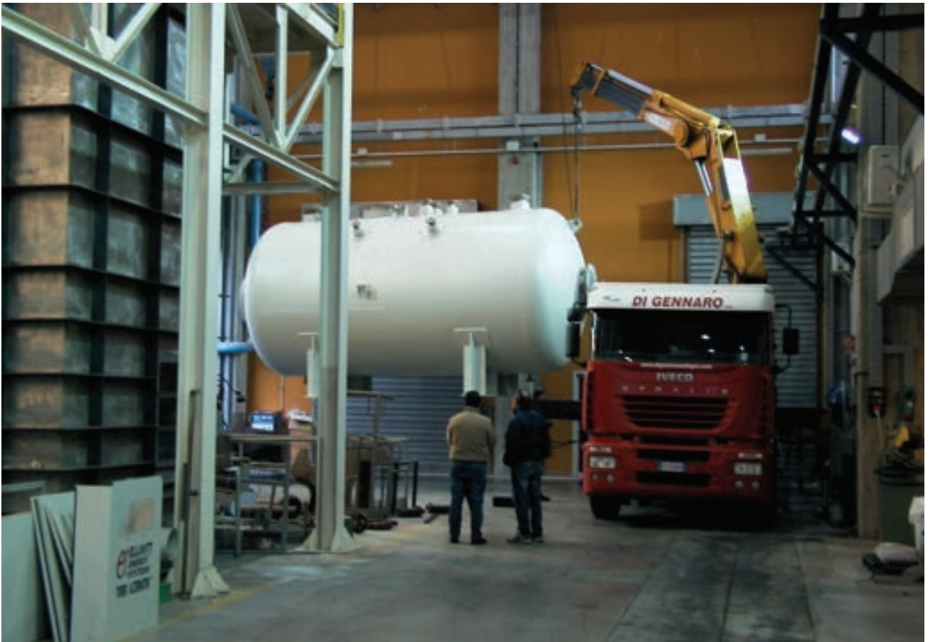
Figura 12: Fasi di scarico del vessel
