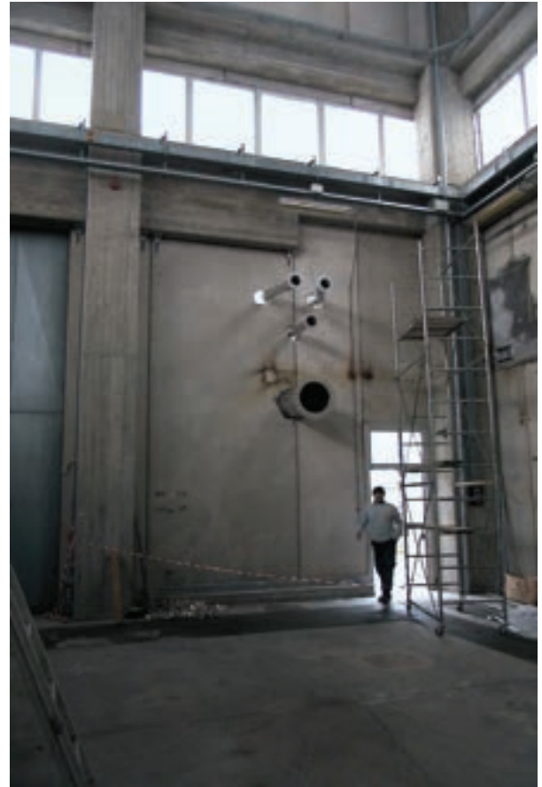
Figura 18: connessioni camino attraverso la parete
