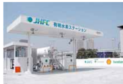
Stazione idrogeno Ariake (Tokyo)
