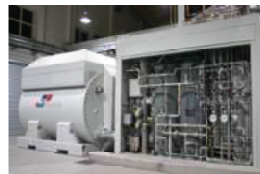
Sistema HM 300 alimentato a biogas (Leonberg)
