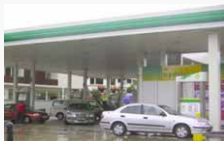
Stazione idrogeno BP (Singapore)
