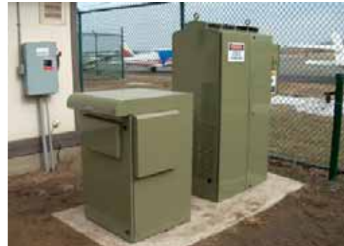
Unità GenCore e modulo di accumulo idrogeno
