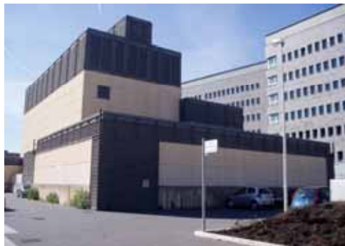
Impianto PAFC da 1.3 MW Milano-Bococca
