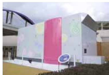
Sistema MHI presso l'Electric Power Pavilion dell'Expo di Aichi
