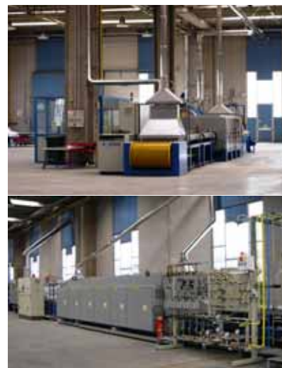
Linee di fabbricazione componenti di stack (Stabilimento AFCo, Terni)
