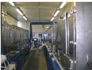
Impianto TEA per la produzione elettrodi (Ponte di Archimede)
