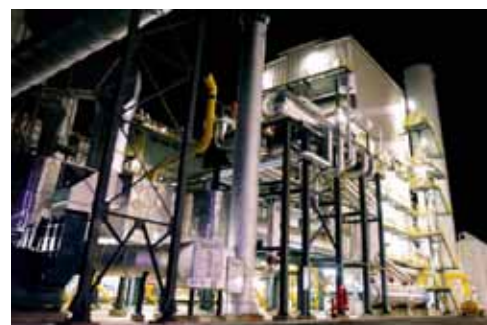
Impianto di steam reforming realizzato dalla Linde (Milazzo, Italia) - Capacità produttiva 65.000 Nm 3 /h
