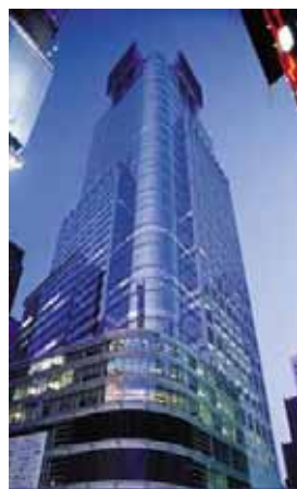
L'edificio di Times Square in cui sono installate due unità PureCell della UTC Power
