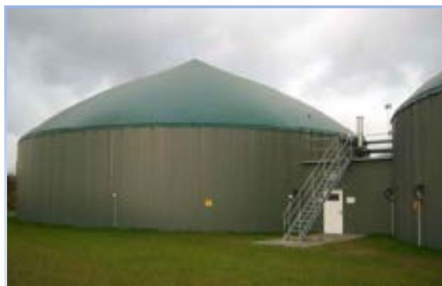
Figura 4 - Esempio di reattore CSTR
