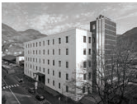
Vista dell'edificio dopo l'intervento.
