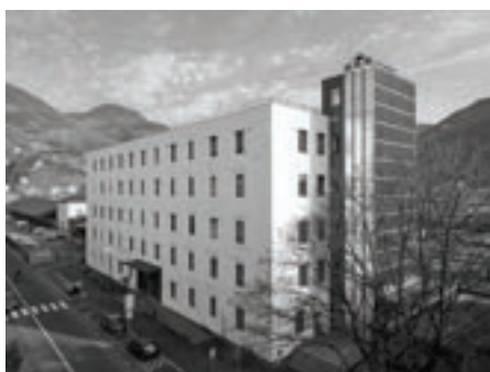
Fig.1: Vista dell'edificio dopo l'intervento.
