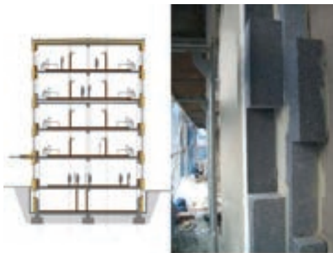
Fig.6: Sezione e foto che illustrano l'isolamento aggiunto alle pareti originali dal progetto di retrofit.
