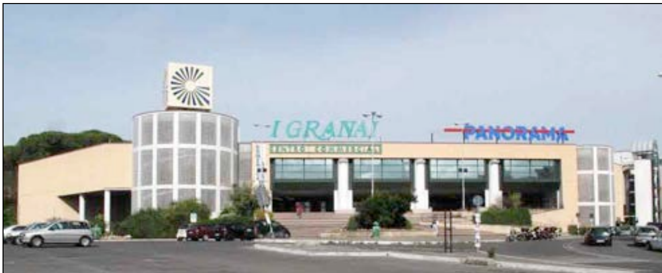
Foto 2 – Vista dell'ingresso principale al Centro Commerciale
