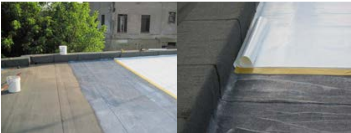
Figura 4: Stesura del biadesivo sulla membrana
