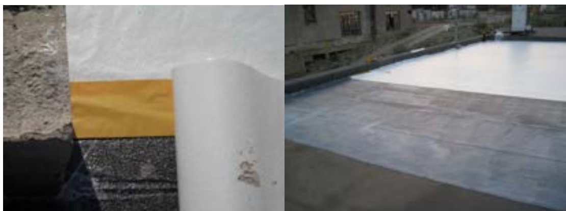
Figura 5: Sovrapposizione della membrana alla striscia di biadesivo
