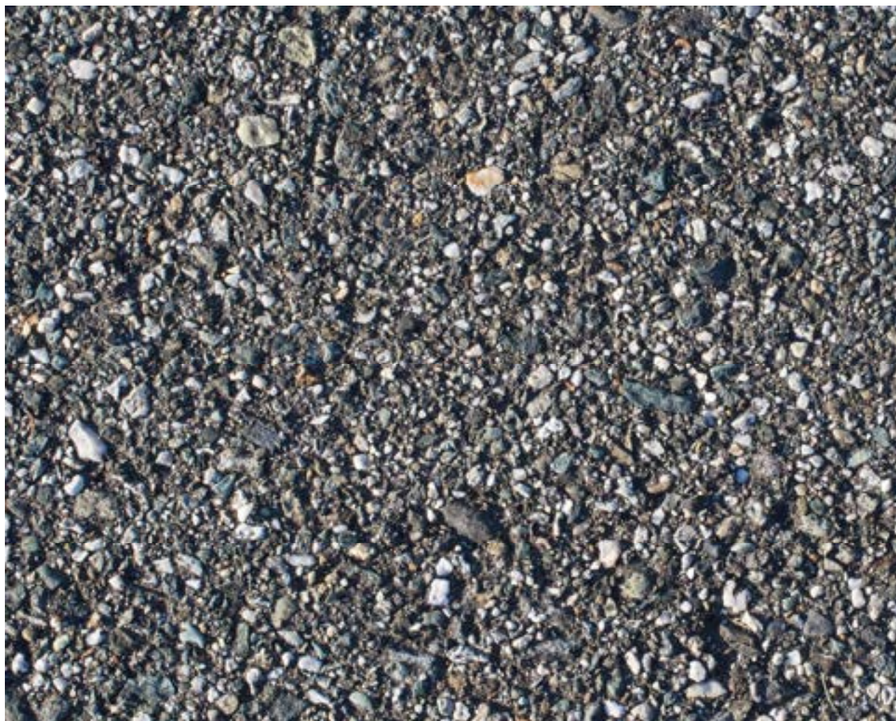
Figura 9 Sito sperimentale: particolare dell'asfalto non trattato.
