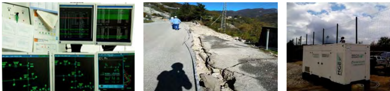
Figura 8. Operazioni nelle prime ore successive all'evento: a) centro di telecontrollo dal quale sono state eseguite manovre in remoto; b) ispezioni degli impianti e del territorio circostante; c) distribuzione di gruppi elettrogeni per alimentare ponti radio e torri faro.
