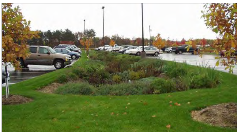
Figura 2.19 – Canale inerbito realizzato in un parcheggio [ http://www.minnehahacreek.org ]
