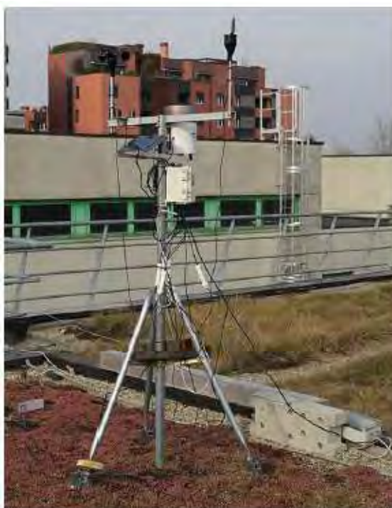
Figura 3.10: stazione meteorologica installata sulla copertura sperimentale
