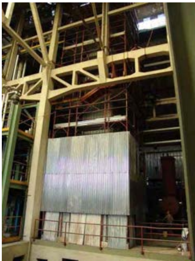
Fig. 4 – 23/05/10, allestimento ponteggio dal 5° piano
