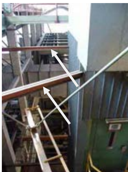
Fig. 10a - Strutture di sostegno da rimuovere sopra il 9° piano
