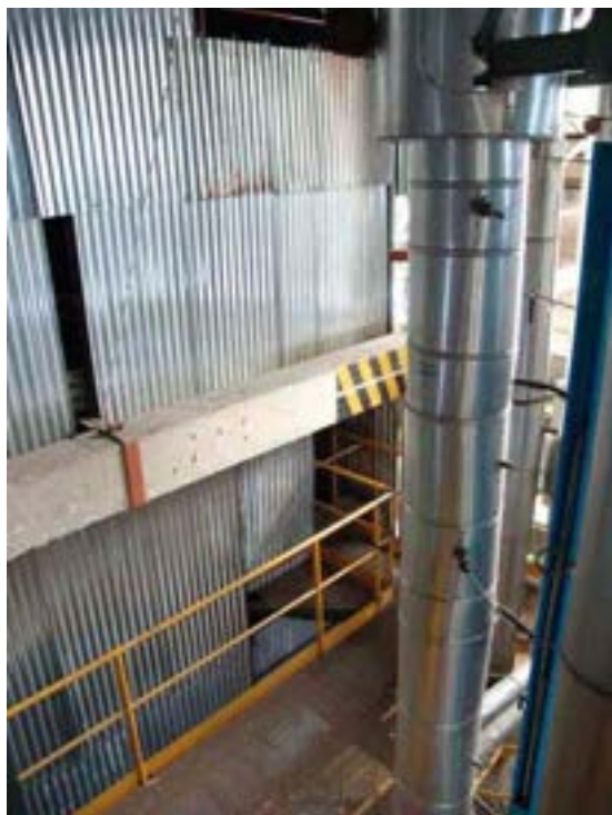
Fig. 7 – 31/5/10 completamento delle opere di sigillatura al 6° piano struttura
