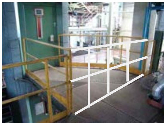
Fig. 15 - Riposizionamento ringhiera al 4° piano
