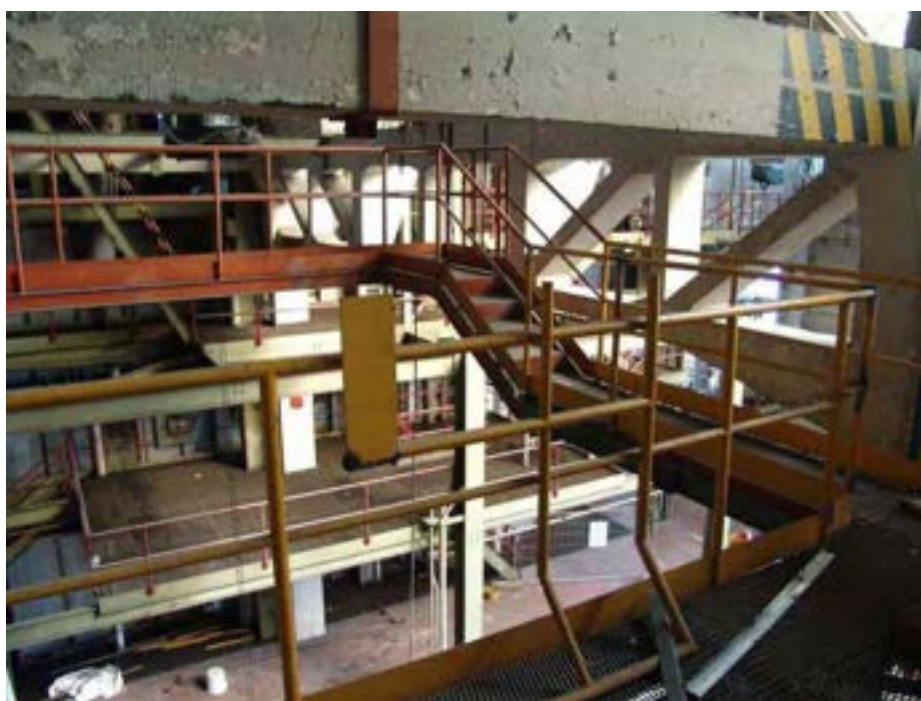
Fig. 27– 23/6/10, lavori ultimati al 7° piano
