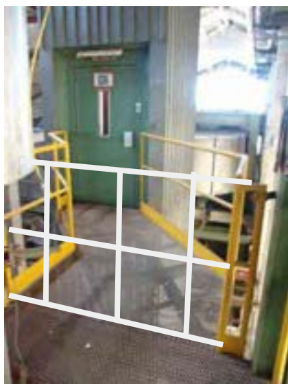
Fig. 18 - Riposizionamento ringhiera al 7° piano
