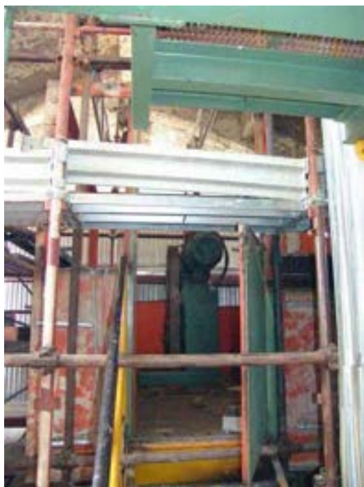
Fig. 11 – 14/6/10 fasi di smantellamento della cabina di comando
