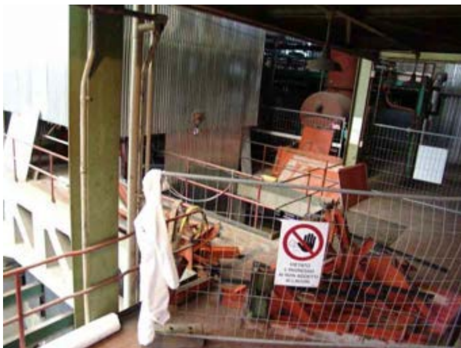
Fig. 19– 15/6/10, area di lavoro al 5° piano
