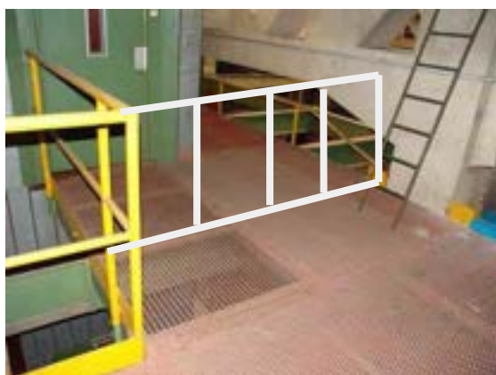
Fig. 13 - Riposizionamento ringhiera al 2° piano
