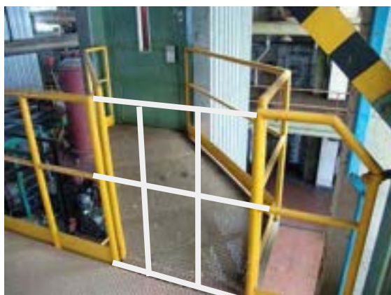
Fig. 16 - Riposizionamento ringhiera al 5° piano
