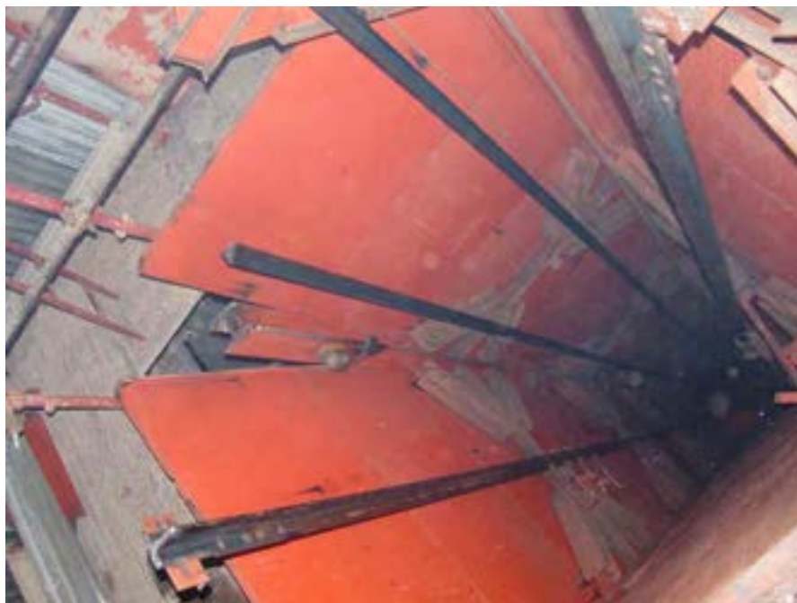
Fig.15 – 14/6/10, lavori al vano ascensore visto dal 5° piano
