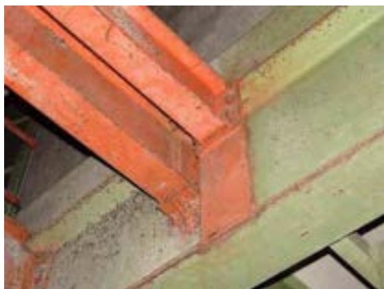
Fig. 8b - Particolare del collegamento
