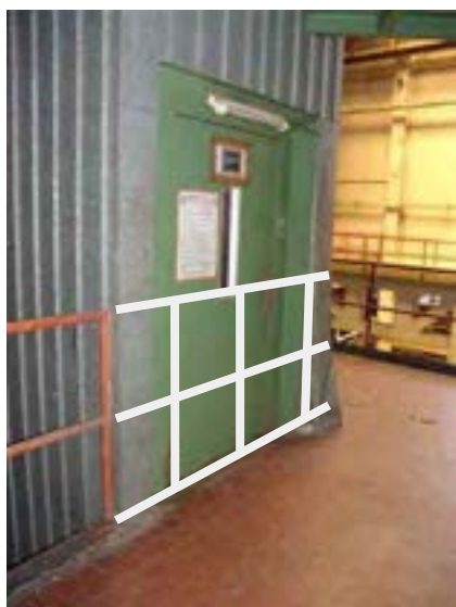
Fig. 14 a - Riposizionamento ringhiera al 3° piano
