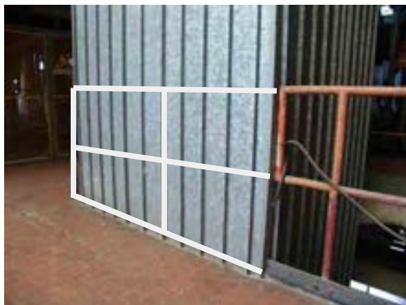
Fig. 14 b - Riposizionamento ringhiera al 3° piano
