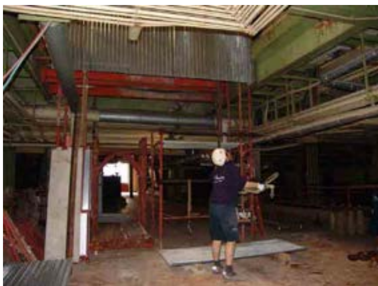
Fig. 5 – 23/05/10, lavori di allestimento ponteggio al piano terra
