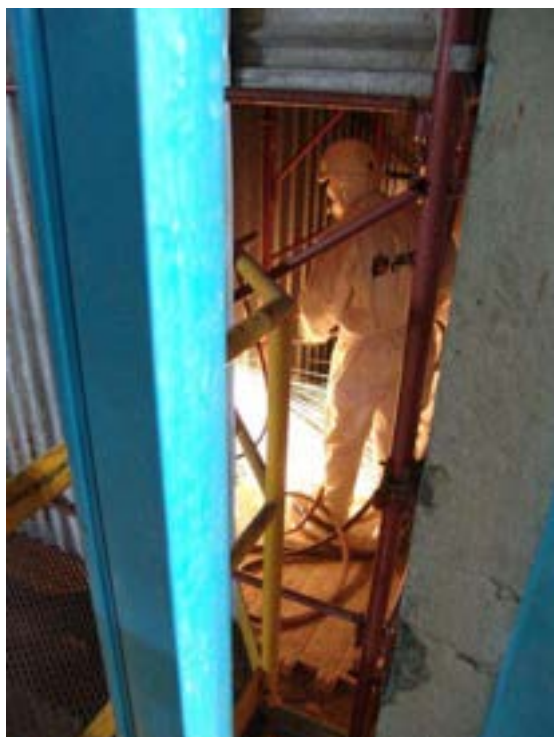
Fig. 8 – 3/6/10 operai al lavoro per la rimozione della lamiera esterna
