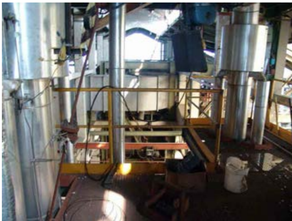
Fig. 26 – 23/6/10, lavori ultimati al 8° piano
