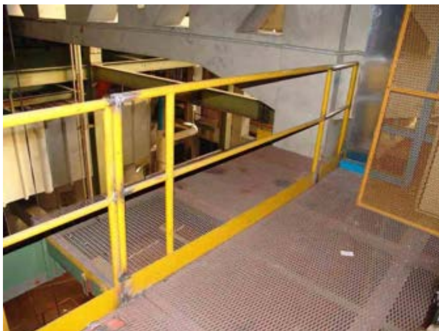
Fig. 30 – 23/6/10, lavori ultimati al 4° piano
