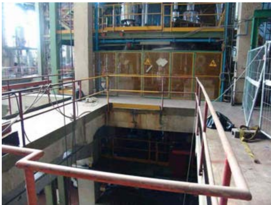
Fig. 29 – 23/6/10, lavori ultimati al 5° piano
