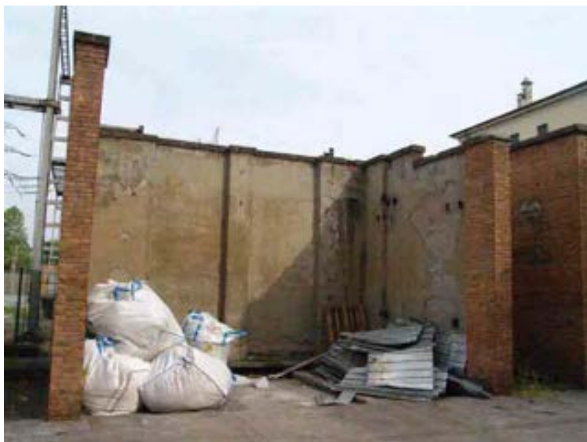
Fig. 10 – 8/6/10 big bags contenenti coibentazione asportata e lamiera grecata nel deposito esterno
