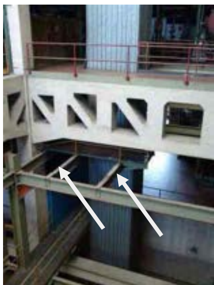
Fig. 9 - Strutture da rimuovere al 4° piano SPES-2
