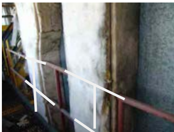
Fig. 20 - Riposizionamento ringhiera al sottotetto
