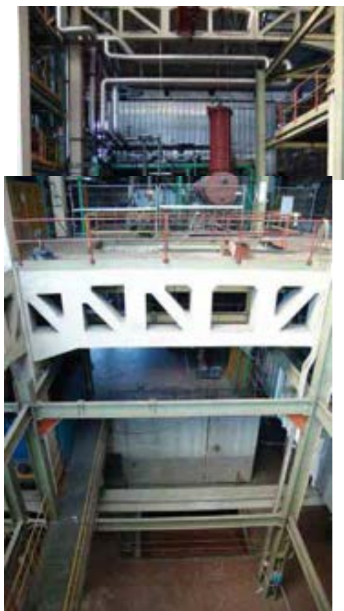
Fig. 33 – 24/6/10 vista complessiva dell'area senza il montacarichi
