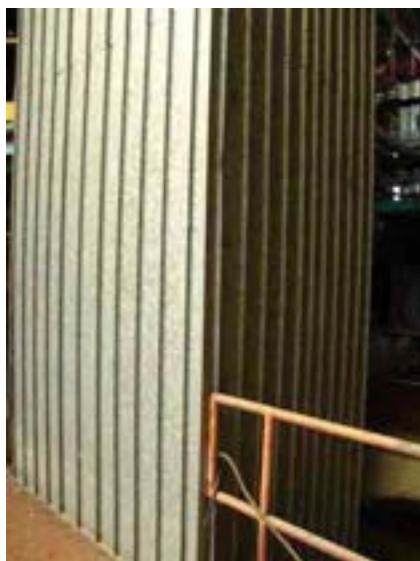
Fig. 3 - Lamierino che contiene la coibentazione
