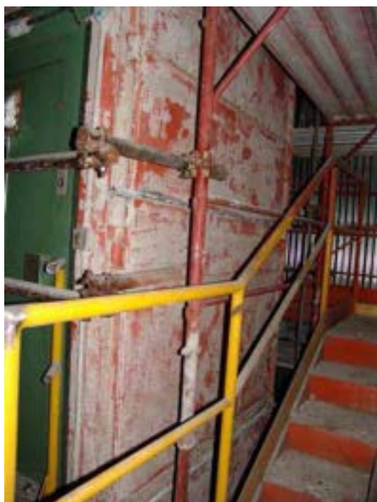
Fig. 9 – 8/6/10 vano ascensore con coibentazione rimossa
