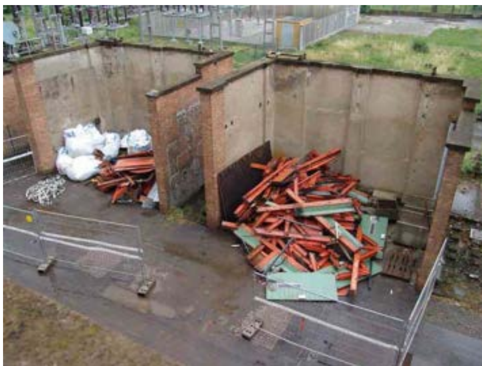
Fig. 21 – 16/6/10, deposito esterno material di risulta
