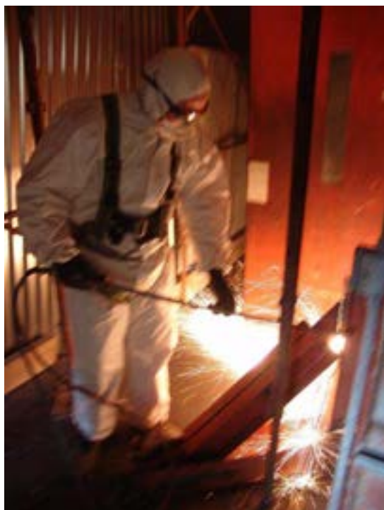
Fig. 16 – 15/6/10, operai al taglio delle strutture portanti
