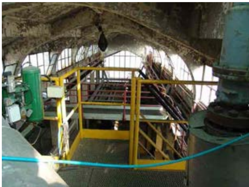
Fig. 25 – 23/6/10, lavori ultimati all'ultimo piano della struttura
