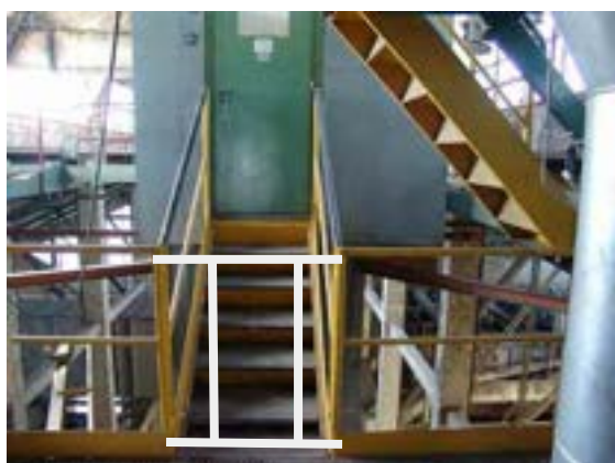
Fig. 19 - Riposizionamento ringhiera al piano del vano motore
