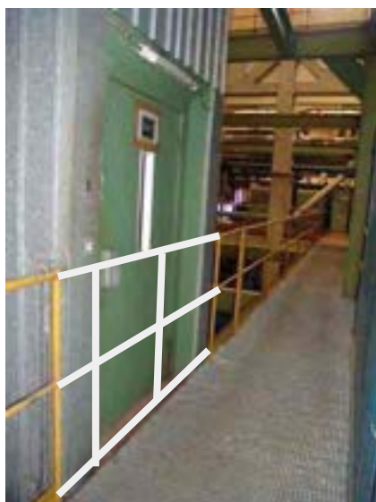
Fig. 12 - Riposizionamento ringhiera al 1° piano
