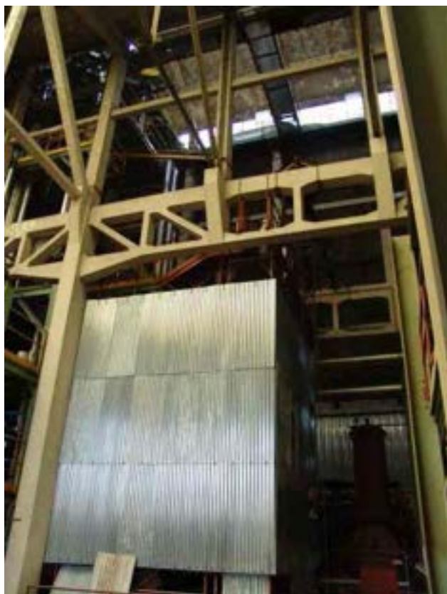
Fig. 24 – 21/6/10, smontaggio del ponteggio
