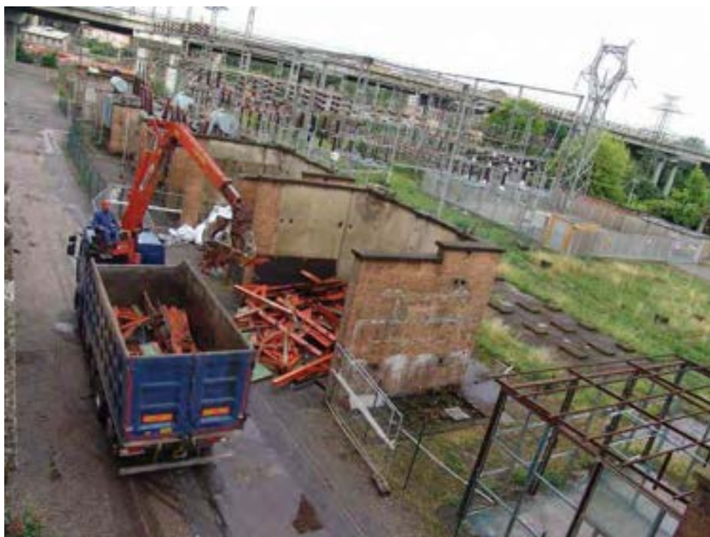
Fig. 22 – 18/6/10, prelievo dei material ferrosi dal deposito esterno
