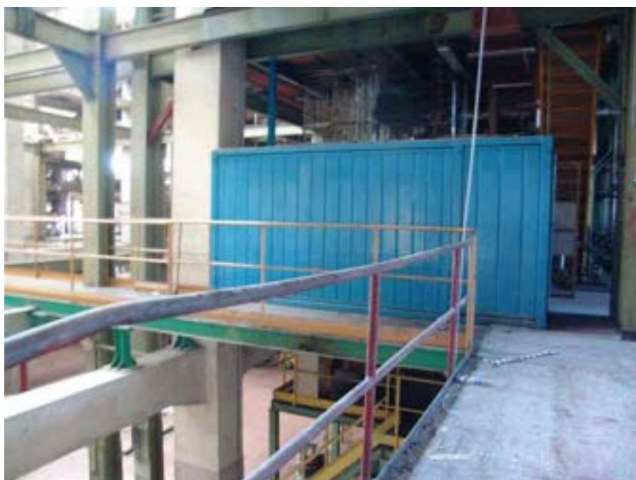
Fig. 31 – 23/6/10, lavori ultimati al 3° piano
