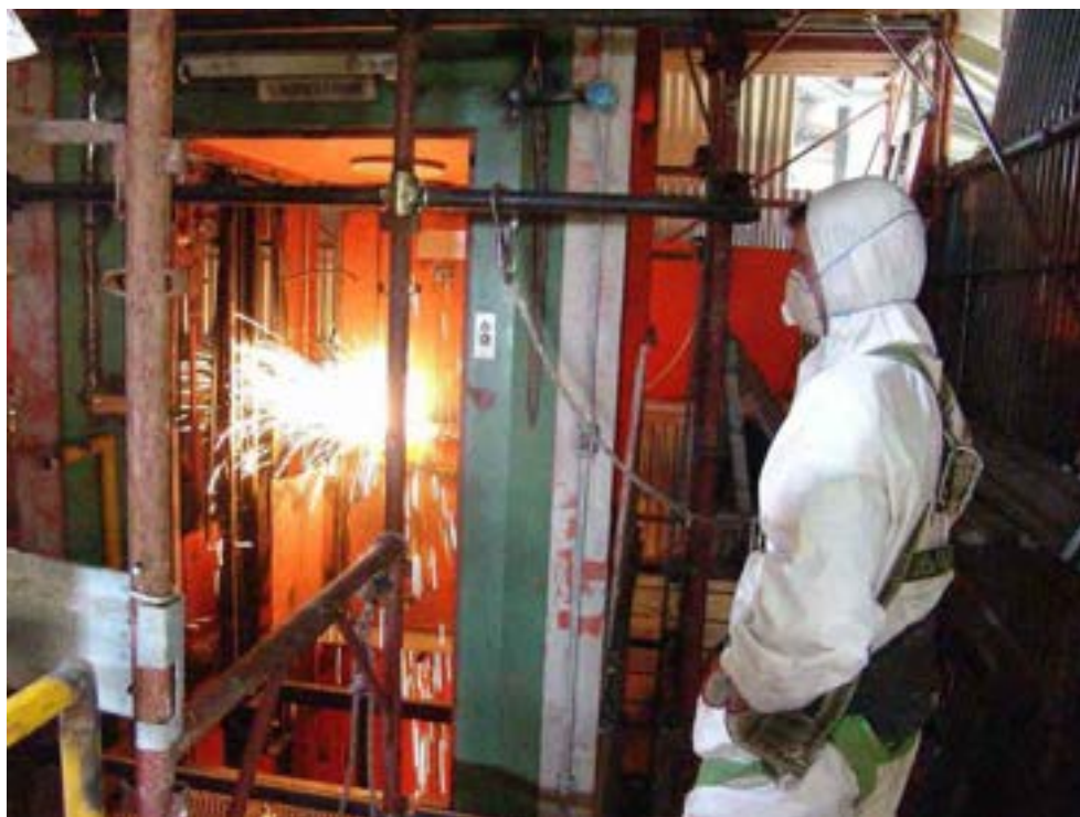
Fig. 12 – 14/6/10 operai al lavoro per la rimozione del vano ascensore
