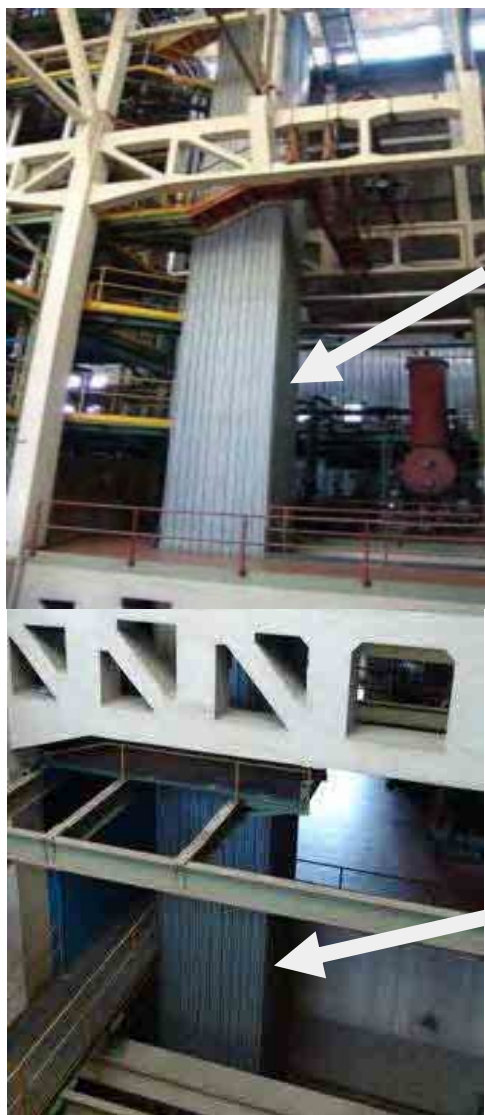
Fig. 1 – Sviluppo parziale del montacarichi nel vano che ospiterà il nuovo impianto
