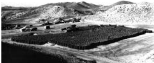
Contenitori di materiale contaminato in attesa di essere spediti al deposito negli Stati Uniti.
