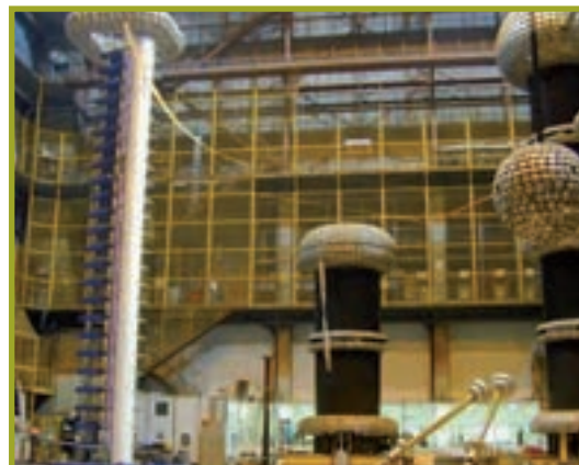
Panoramica del salone AT con generatore di impulsi e trasformatori elevatori
