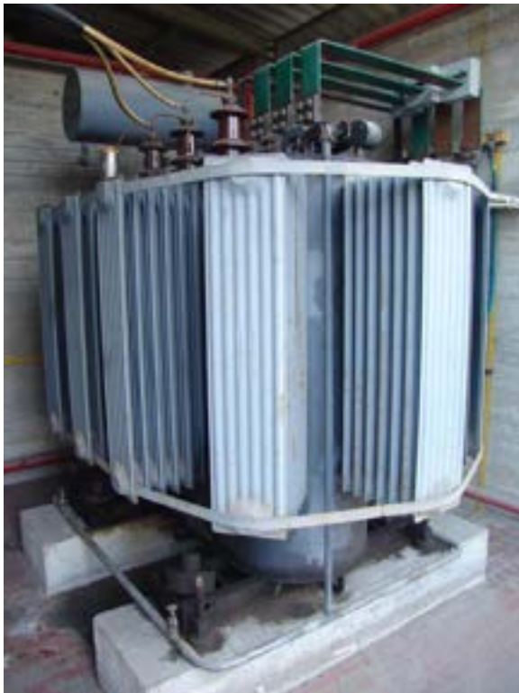
Figura n. 39 - Cabina GEST: Trasformatori 3000 / 380V (TR-1 e TR-2)
