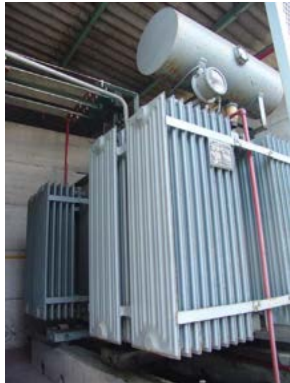
Figura n. 39 - Cabina GEST: Trasformatori 3000 / 380V (TR-1 e TR-2)
