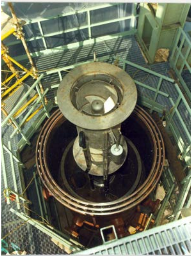
Figura n. 20 - Separatore in fase di installazione nel Vessel dell' impianto GEST-SEP
