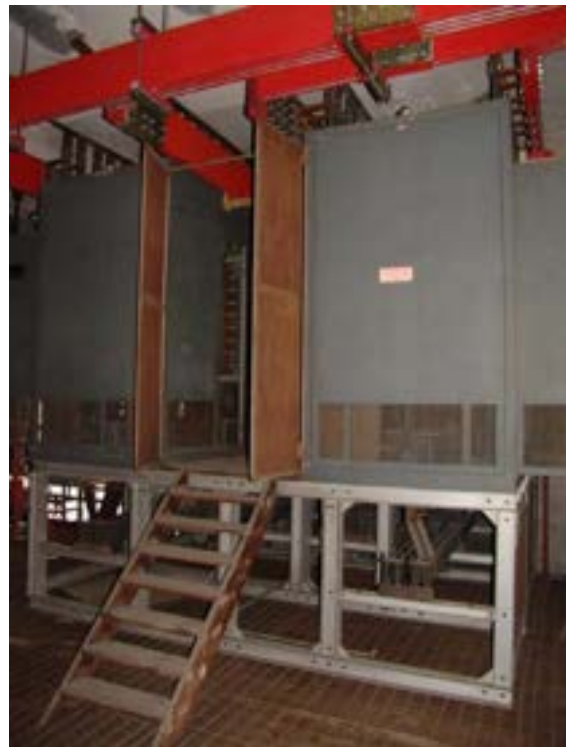
Figura n. 43 Armadio a Diodi Gruppo di Potenza 8 MW
