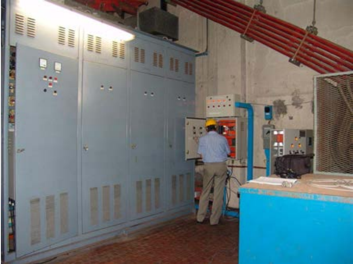
Figura 12 - Lavori di manutenzione al gruppo di raddrizzamento 4 MW
