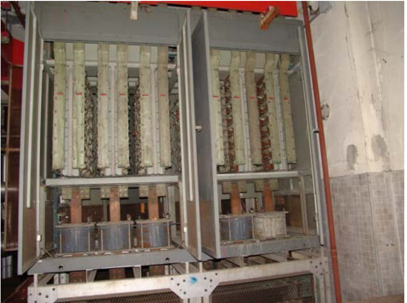
Figura 5 - Gruppo 8 MW C.G.E. zona raddrizzatori
