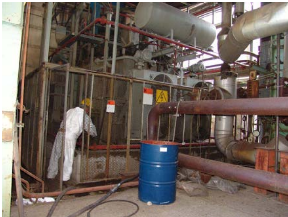
Figura 6 a,b - Lavori di manutenzione sul gruppo 8MW
