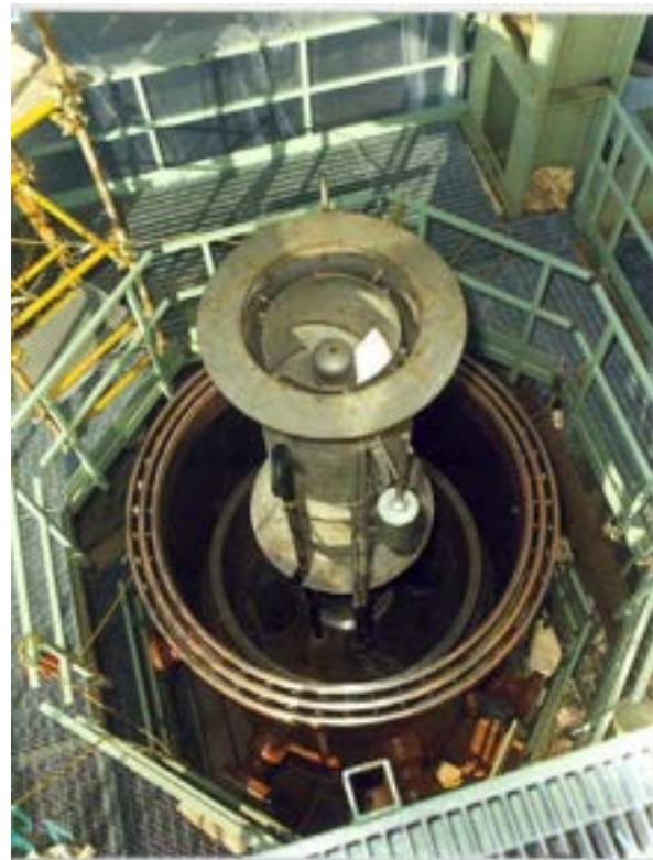
Figura 52 - SEPARATORE IN PROVA SU IMPIANTO GEST-SEP
