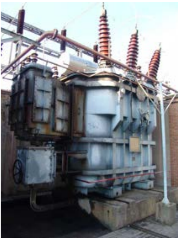
Figura 11 - TRASFORMATORE 130 / 3 KV
