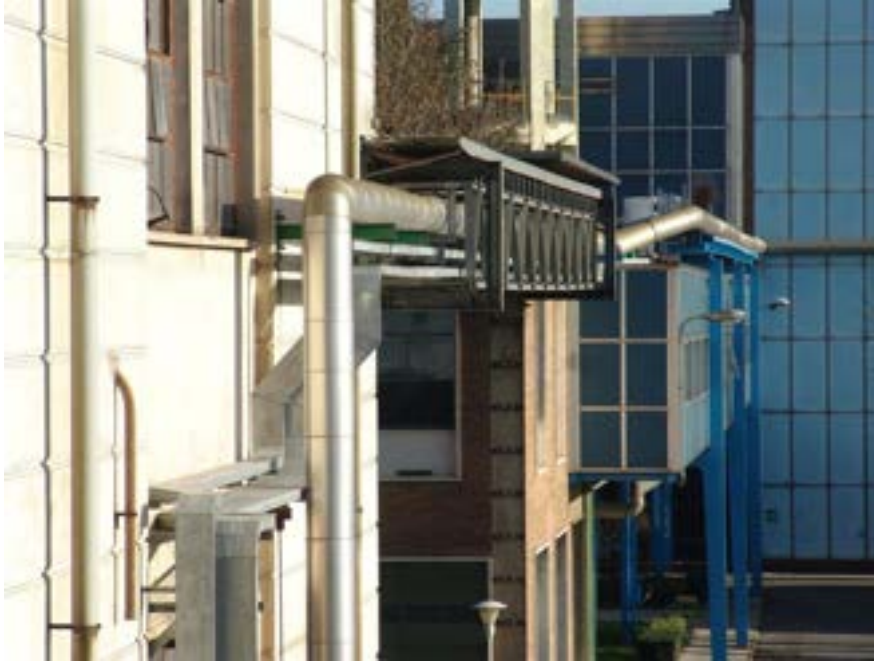
Figura 13 - LINEA 5" VAPORE SURRISCALDATO DA CENTRALE EDIPOWER
