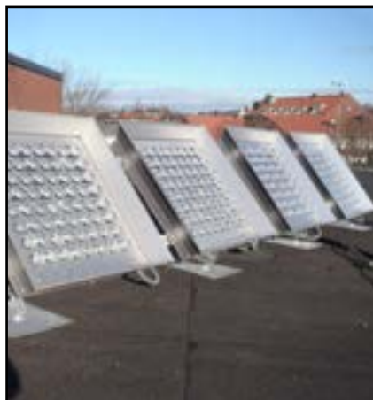
Figura 1.70. Università di Lund, Svezia, impianto di illuminazione a fibre ottiche: pannelli solari di captazione.
