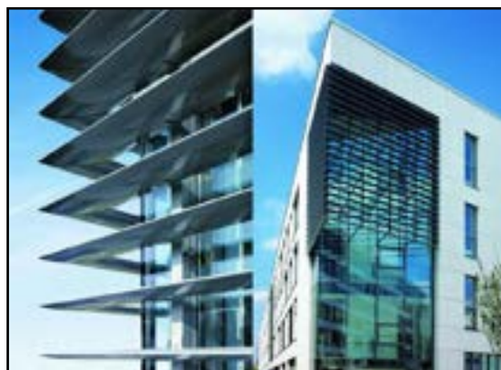
Figura 1.14. Applicazione di lamelle fisse di grandi dimensioni
