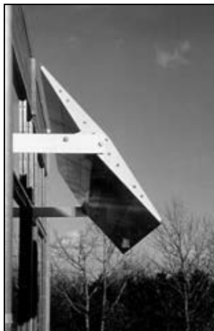
Figura 1.8. Esempio di light-shelf mobile esterno.
