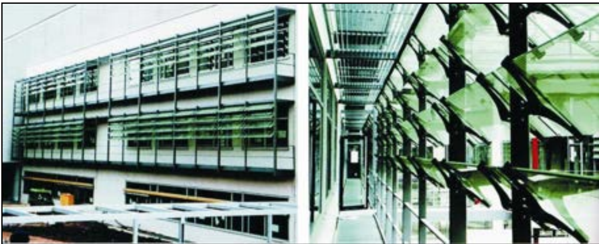
Figura 1.15. Frangisole a lamelle di vetro
