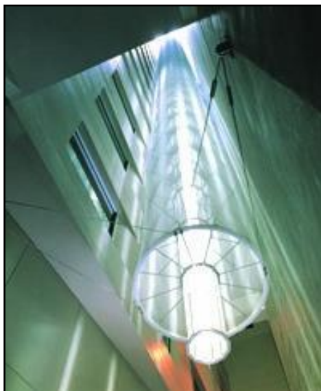
Figura 1.68. Eliostato e solar tube, Uffici, Washington (USA)
