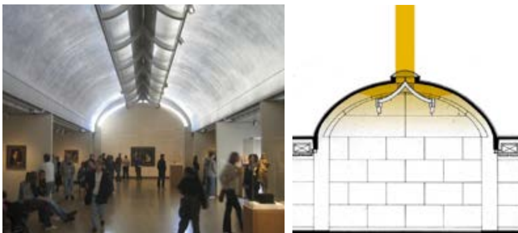
Fig. 117 - Kimbell Museum of Art, Fort Worth, Texas. Il progetto di Louis Kahn si compone di una serie di tunnel affiancati, coperti da volte cicloidali che integrano un dispositivo capace di schermare la luce diretta e rinviarla verso la superficie delle volte che diventano così dei grandi diffusori.
