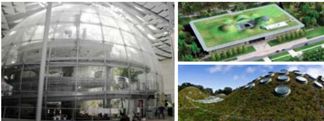
Fig. 126 - Museo "sostenibile" della California Academy of Science, di Renzo Piano. I grandi volumi della biosfera tropicale e del Planetario sporgono dal tetto verde e prendono luce dai numerosi lucernari. 1 - Isolamento realizzato con materiali naturali o riciclati; 2 - controllo climatico passivo; 3 - tetto "vivente"; 4 - luce naturale; 5 - conservazione dell'acqua.
