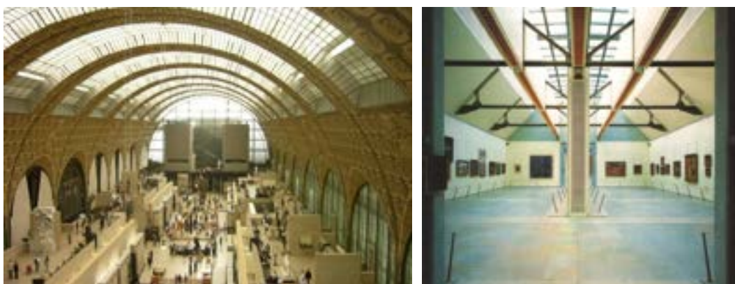
Fig. 118 - Musée d'Orsay, Parigi. Il progetto di Gae Aulenti nasce in funzione del controllo della luce naturale. La luce artificiale è integrata agli stessi sistemi che convogliano la luce diurna (progetto illuminotecnico Piero Castiglioni).
