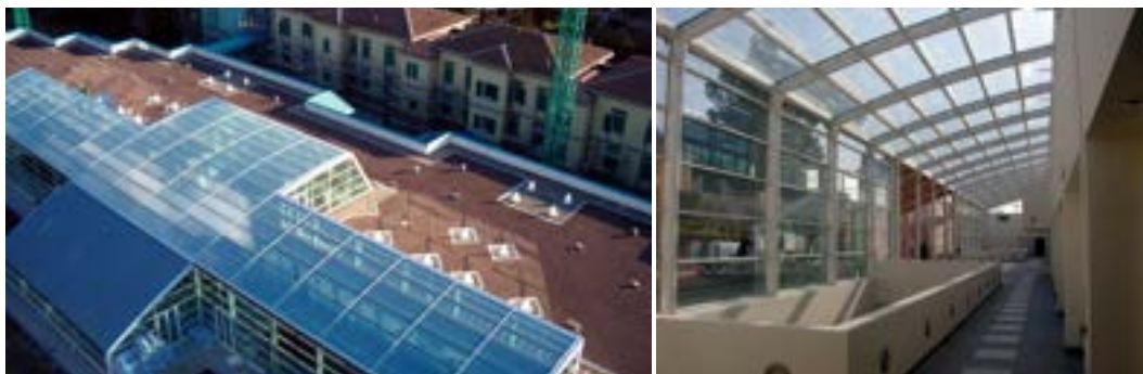
Fig. 108 - Ospedale Meyer a Firenze. Particolare dei percorsi nella grande serra.
