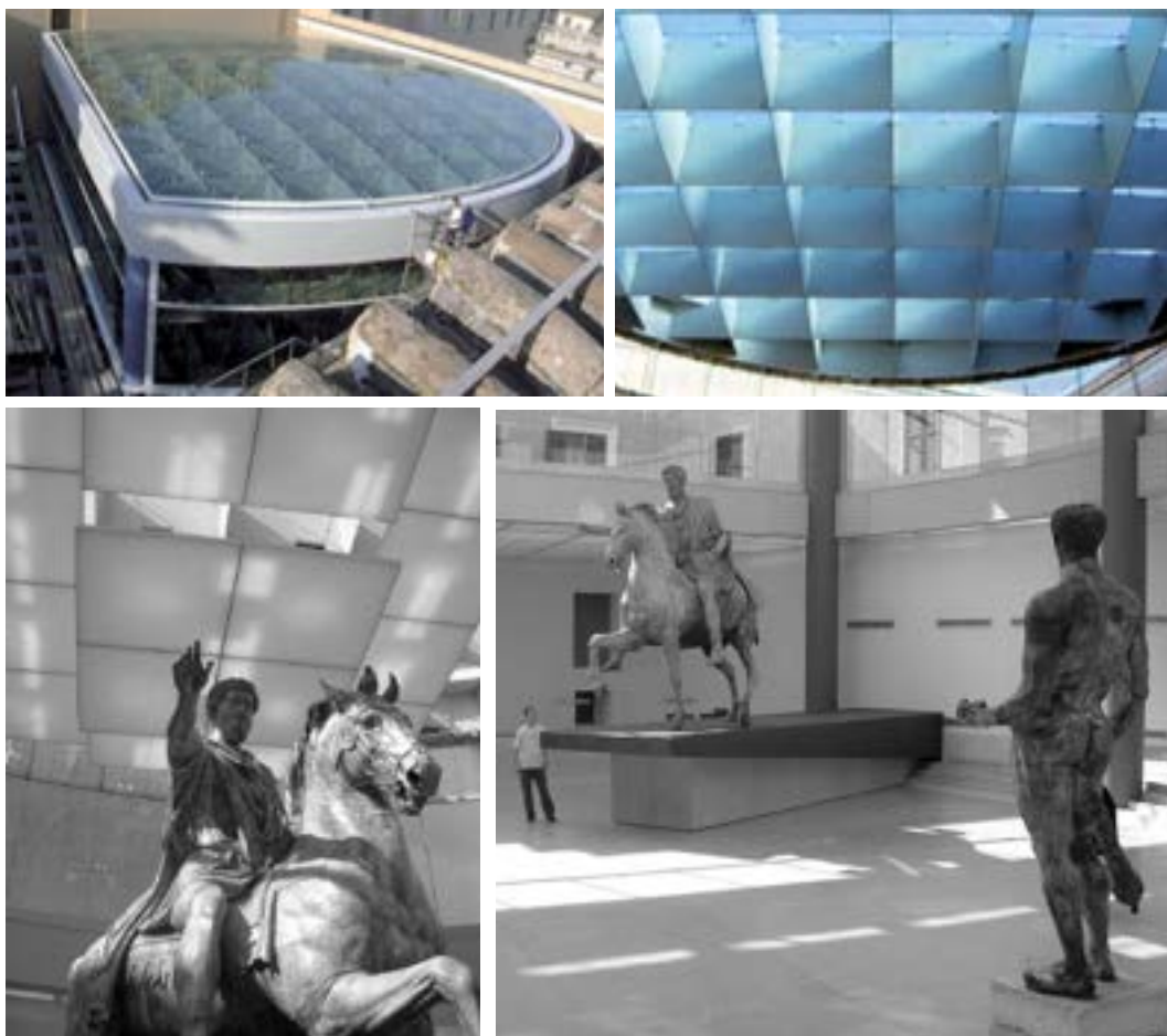
Fig. 122 - Il Giardino Romano dei Musei Capitolini, dove è conservata la statua originale di Marcaurelio, è coperto da un lucernario in vetro opalescente a controllo termico e luminoso le cui lamelle autoregolano anche la ventilazione naturale.
