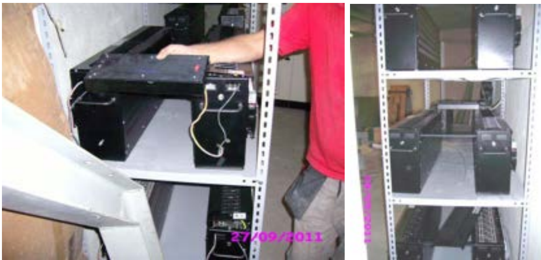
Fig. 14 a) Assemblaggio batterie nel locale di Bergamo b) Disposizione finale
