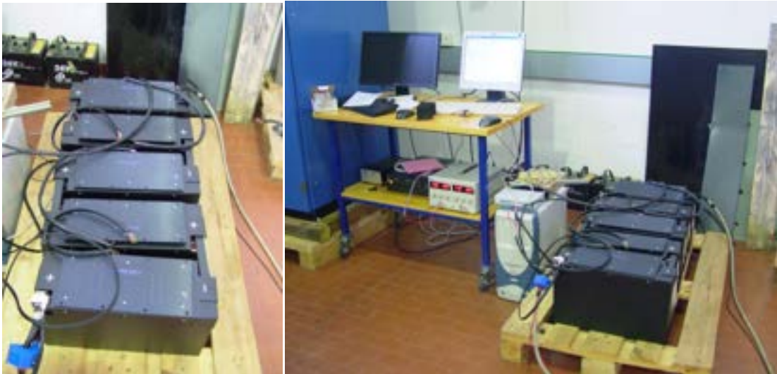
Fig. 1 Pacco batterie EIG da 40 Ah 86 V
