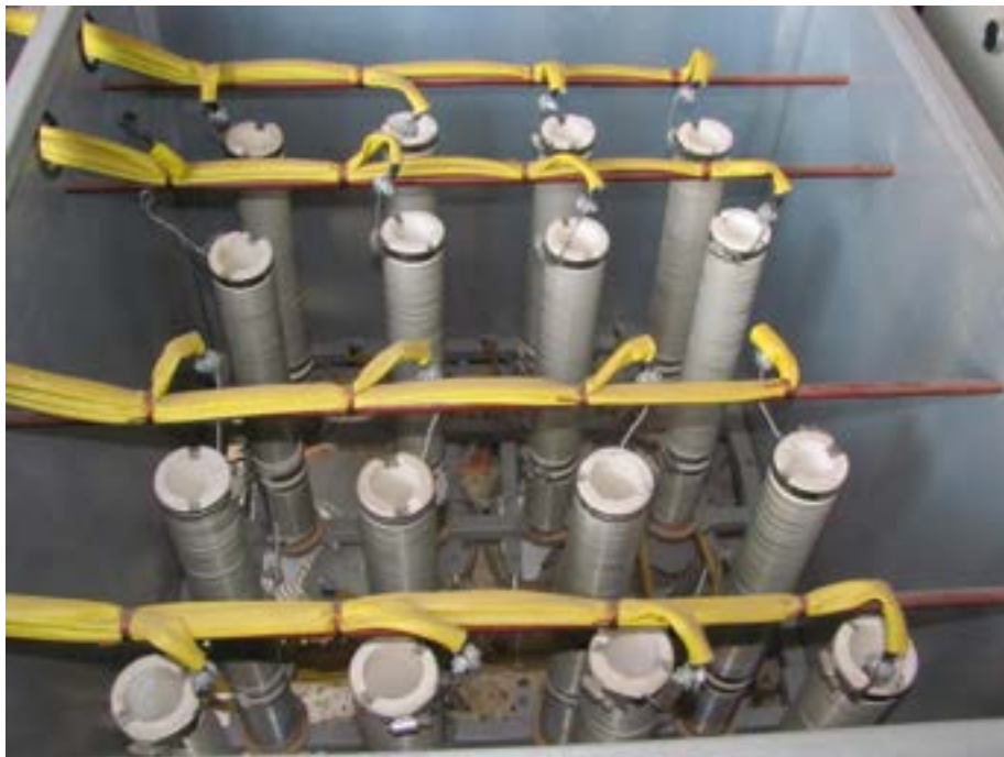
Fig. 4.12 - Banco di resistori monofase da 75 kW.
