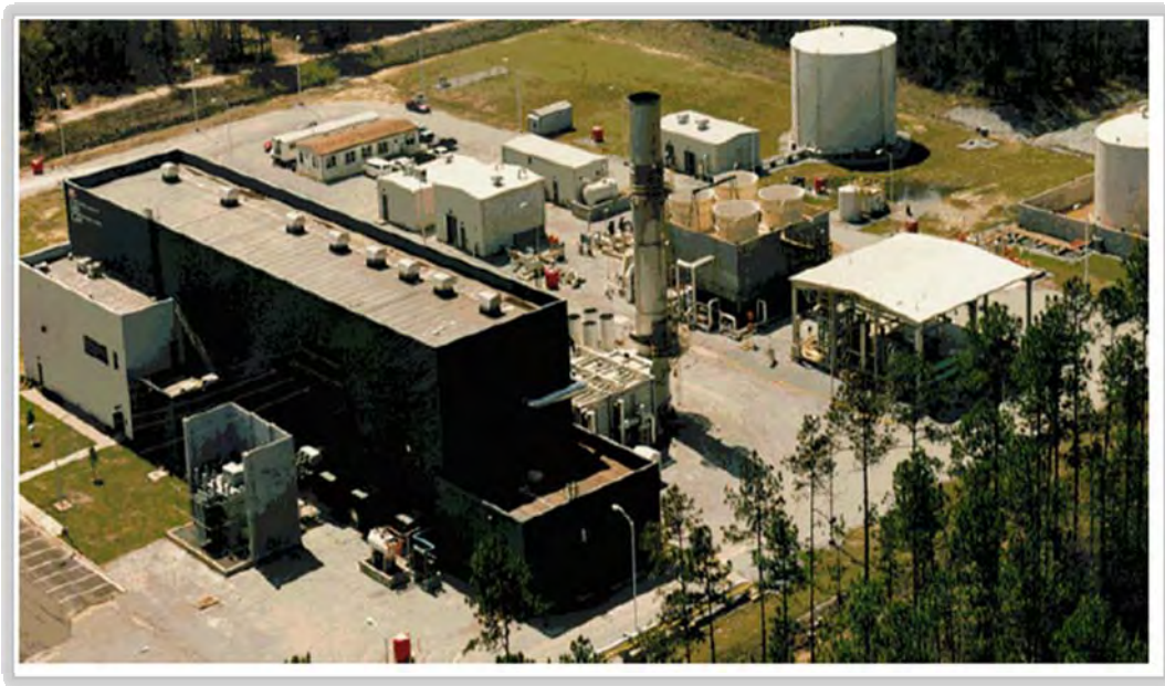
Fig.IV.IV: Impianto CAES di McIntosh (Alabama) [16]
