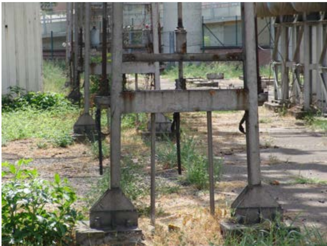
Fig.3 Struttura - Situazione prima dell'intervento
