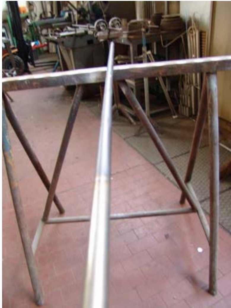
Fig. 5. 1 - Candela scaldante del pressurizzatore
