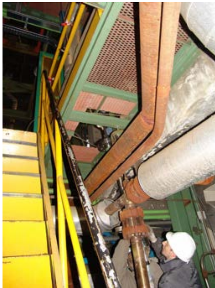
Fig. 6. 3 - Fasi di montaggio: inserimento barre dal piano 3° della Centrale Emilia
