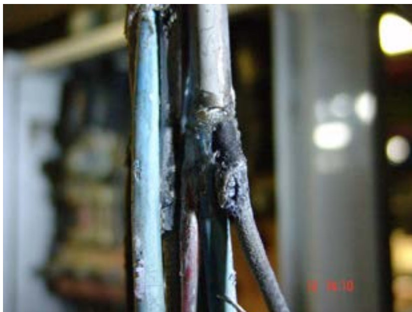
Fig.7. 2 – Terminazioni elettriche delle barre con guaine danneggiate
