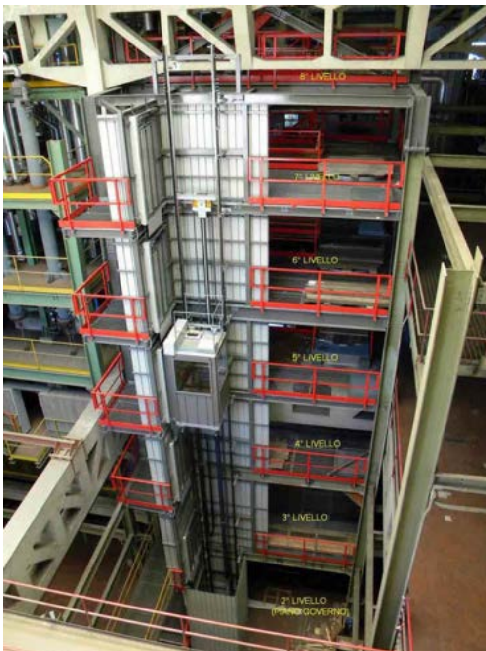
Foto1: Struttura metallica SPES-3, parte bassa (livelli da 2° a 8°)
