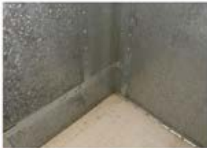
Figura 1 – Particolare delle flange e del pavimento
